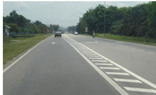
Figure A.5: Terre-plein central à hachures peintes. (Source: iRAP)
