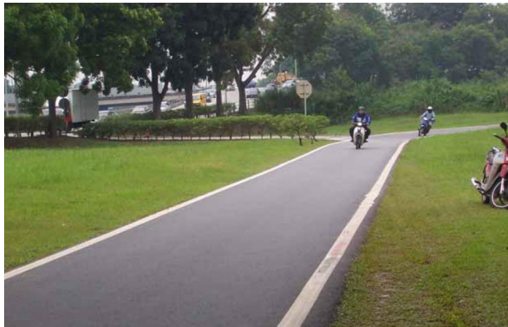
Figure A.9: Voie réservée aux motocyclistes (source: Turner & Smith 2013 47 )
