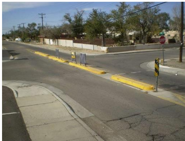
Figure A.6: Le terre-plein central étroit empêche les demi-tours à l'intersection. (Source: FHWA)
