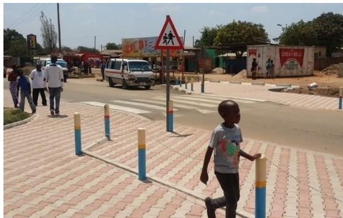
Figure A.8: Passage piéton intégrant des dispositifs de réduction de la vitesse. (Source: Lusakatimes , 2019)
