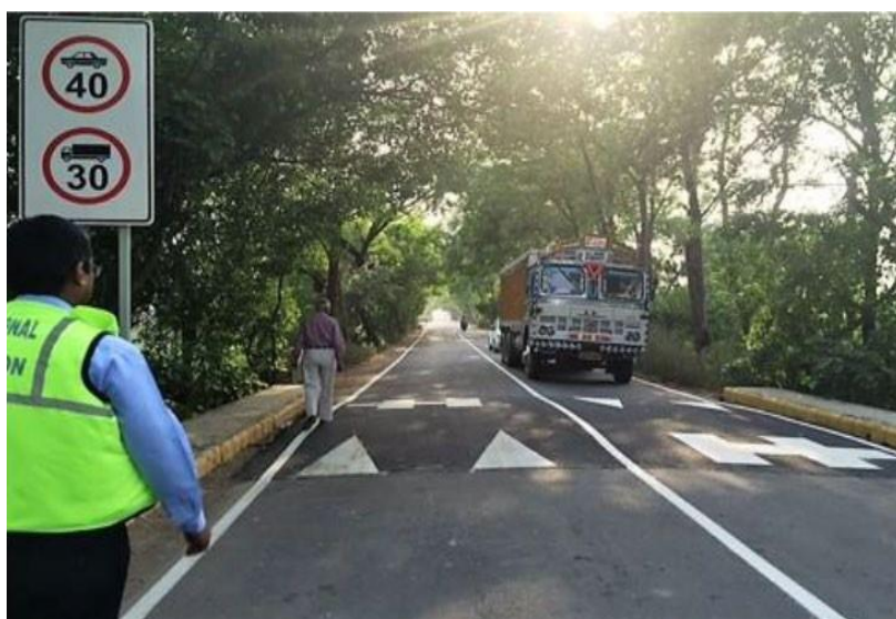
Figure A.17: Zone de ralentissement entre une zone à grande vitesse et une zone à vitesse réduite (Source: Banque mondiale)
