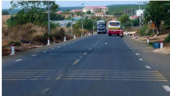
Figure A.12: Exemple de bandes rugueuses transversales au Vietnam. (Source: Banque mondiale)
