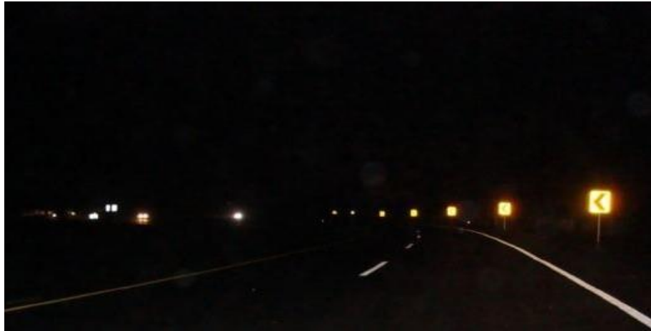
Figure A.10: Exemples de marquage linéaire avec chevrons rétro réfléchissants assurant la visibilité de nuit. (Source: iRAP)
