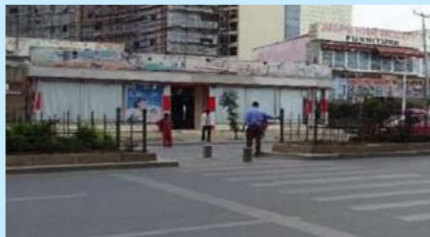
Figure 5.118: Grande ouverture dans le terre-plein central avec bornes en béton
