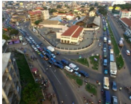
Figure 6.62: Voie d'accès mal délimitée au Ghana.
