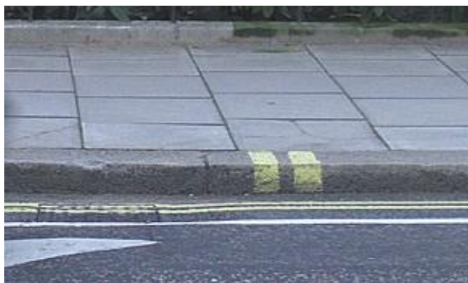
Figure 5.147: Bordure verticale en béton.
