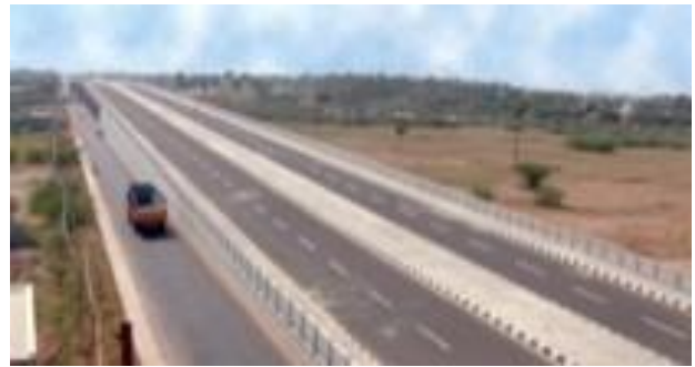
Figure 5.103: Terre-plein central surélevé sur une route à deux voies.
