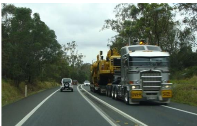
Figure 5.29: Ligne médiane large avec bandes rugueuses centrales dans une courbe en Australie.
