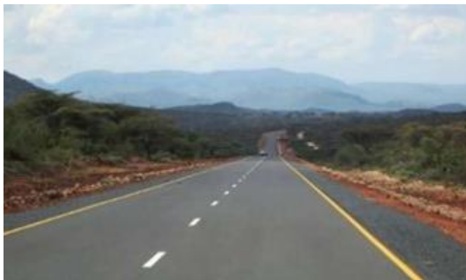
Figure 5.120: Une chaussée asphaltée en bon état.
