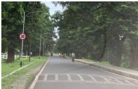
Figure 3.33: Panneau de signalisation et ralentisseur pour établir un point de passage – Inde.
