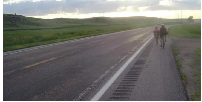
Figure 5.15: Accotement revêtu avec bandes rugueuses utilisé par les cyclistes.
