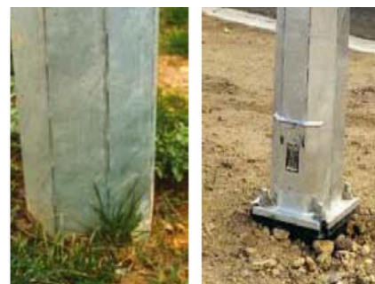
Figure 5.76: Colonnes d'éclairage à absorption d'impact adaptées aux faibles vitesses.
