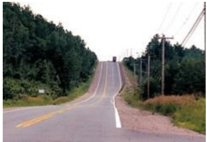
Figure 5.56: Exemple de marquage d'une voie en montée.
