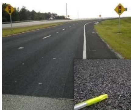
Figure 5.123: Traitement de surface à haut coefficient de frottement dans les courbes à haut risque
