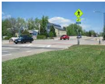
Figure 6.53: Carrefour surélevé avec un panneau indiquant un passage pour piétons.
