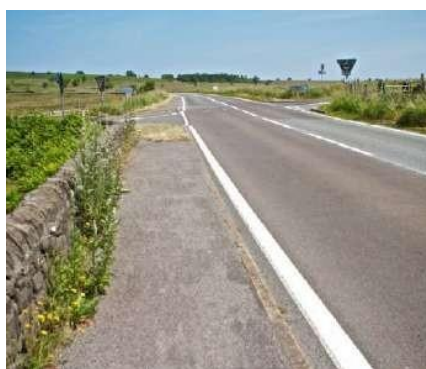
Figure 5.124: Revêtement à haut coefficient de frottement appliqué aux deux approches du carrefour.
