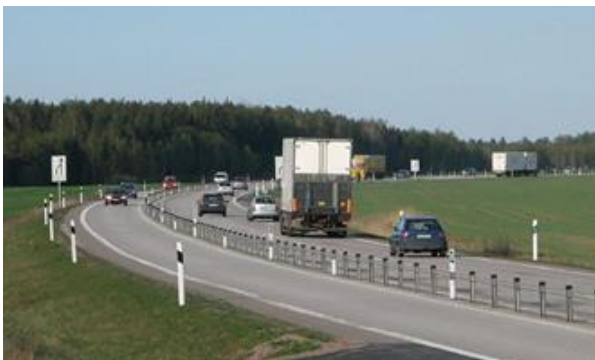
Figure 5.59: Autoroute 2+1 avec glissière flexible.
