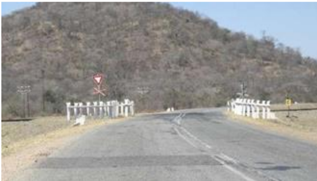
Figure 6.87: Passage à niveau rural au Zimbabwe (passif).
