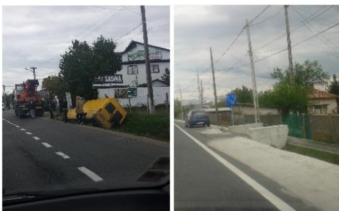
Figure 5.66: Drain non couvert et ponceau dangereux – Roumanie.
