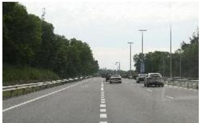
Figure 6.79: Voie d'accélération bien définie au Brunei.
