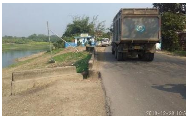
Figure 5.67: Plan d'eau non protégé avec une digue abrupte.
