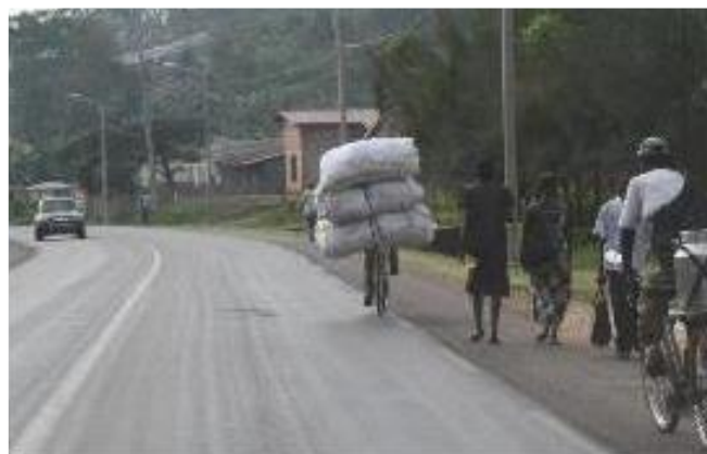
Figure 4.33: Cyclistes sur l'accotement scellé, le revêtement de la chaussée provoquant une différence de niveau – Rwanda.
