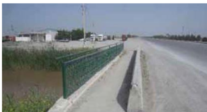
Figure 5.86: Rails à faible calibre avec bordures en béton.
