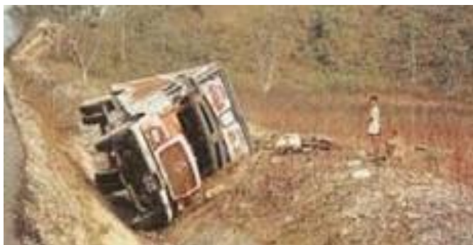
Figure 5.142: Drainage non protégé.
