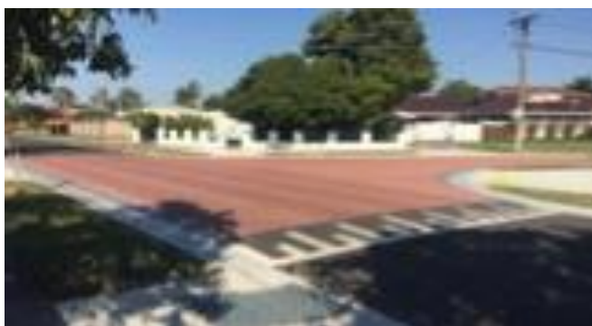
Figure 6.57: Carrefour surélevé et colorée avec marquage au sol.
