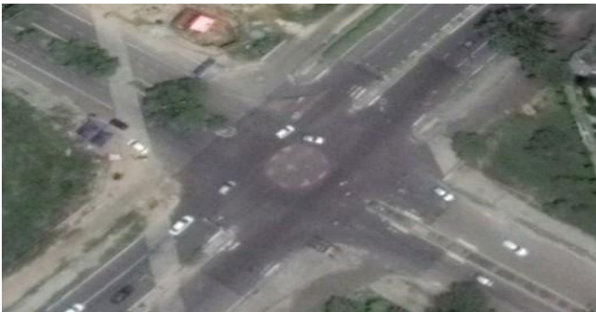
Figure 6.34: Carrefour giratoire avec un îlot central trop petit en Inde.
