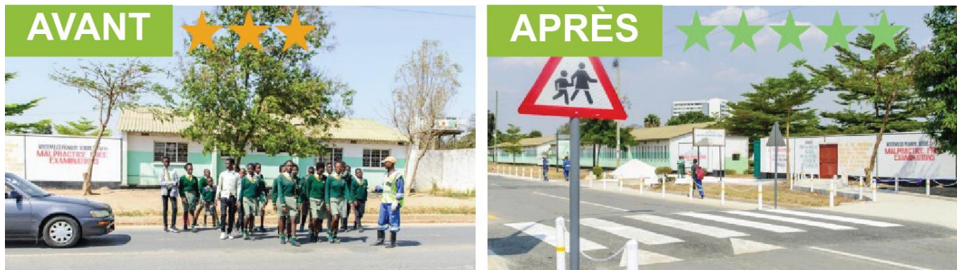
Figure 4.29: Installation d'un passage surélevé avec signalisation et voie piétonne protégée – Zambie
