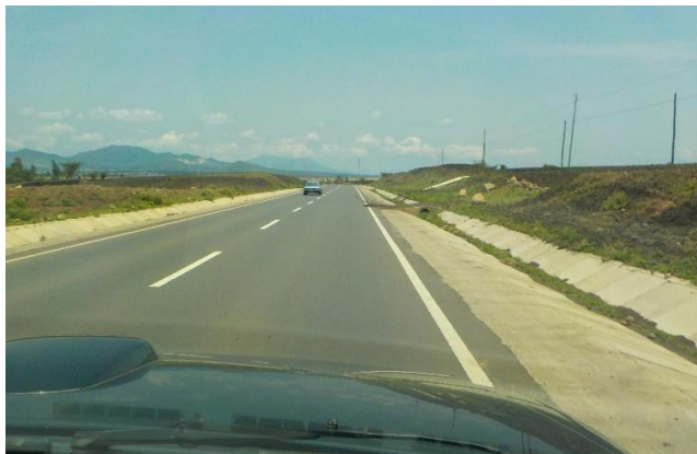
Figure 5.62: Fossé dangereux avec mur de tête (à droite) sur une route à grande vitesse.
