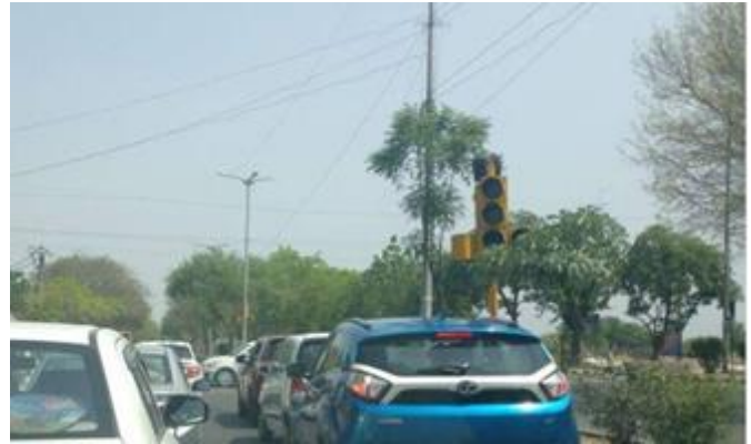
Figure 6.23: Feu de signalisation dysfonctionnel à Dwarka, Inde.
