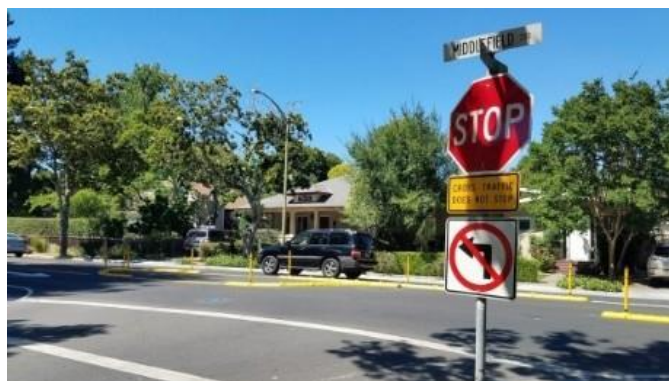
Figure 6.7: Restriction du virage à gauche par des panneaux et un terre-plein central à un carrefour en T sans feux de signalisation.
