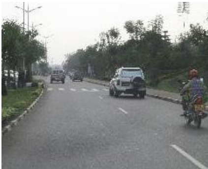
Figure 4.20: Passage piéton bien défini – Rwanda.
