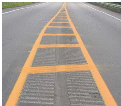
Figure 5.97: Terre-plein central affleurant avec bandes rugueuses.
