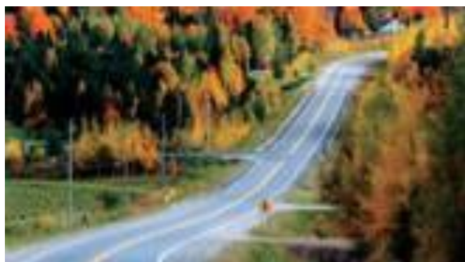
Figure 5.21: Combinaison dangereuse : courbe saillante précédant une courbe horizontale prononcée, avec des carrefours et des voies d'accès.
