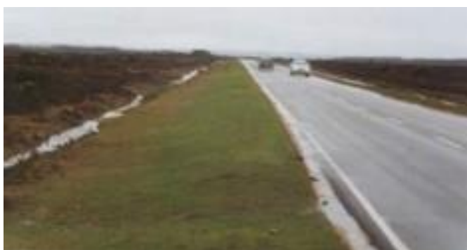
Figure 5.144: Élargissement de l'accotement et drainage en toute sécurité.
