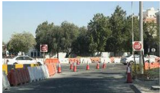
Figure 3.47: Chantier bien signalisé et protégé – Abu Dhabi
