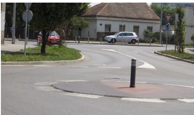
Figure 6.41: Mini-carrefour giratoire avec poteau d'affichage à Zagreb, en Croatie.
