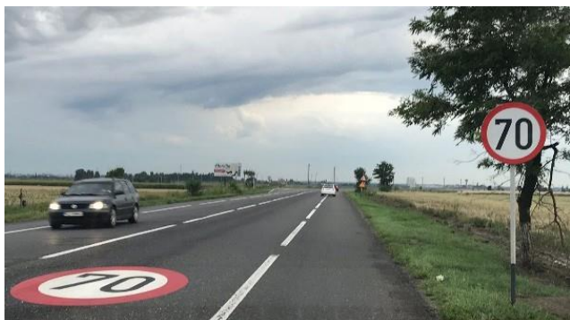
Figure 5.12: Accotement de 2.5 m que les gens utilisent à tort comme voie de circulation – Roumanie
