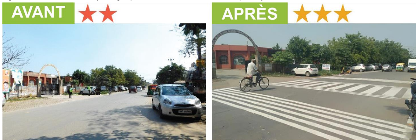
Figure 4.47: Installation de passages piétons avec une zone avancée pour cyclistes – Inde.
