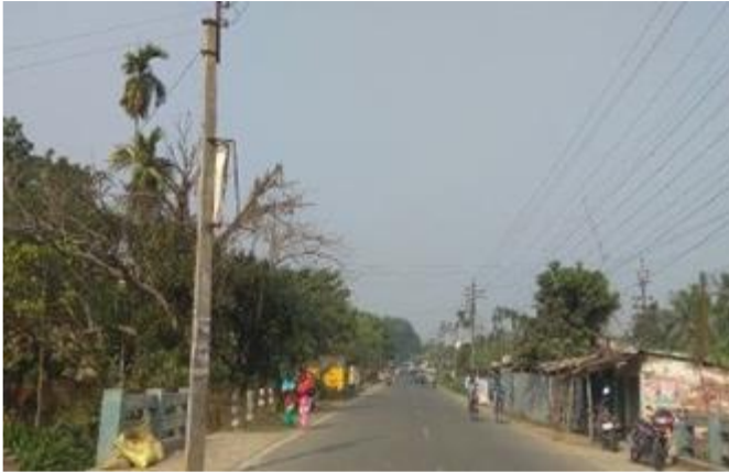
Figure 5.70: Mât rigide sur l'accotement.
