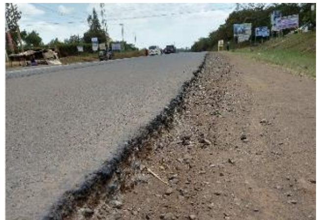
Figure 5.10: Abaissement du bord de la chaussée.
