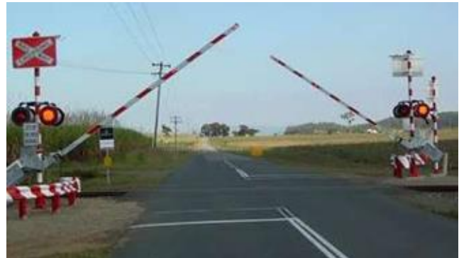
Figure 6.88: Passage à niveau rural en Australie (actif).
