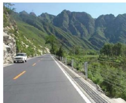
Figure 5.37: Glissière en câble sur la section tangente.
