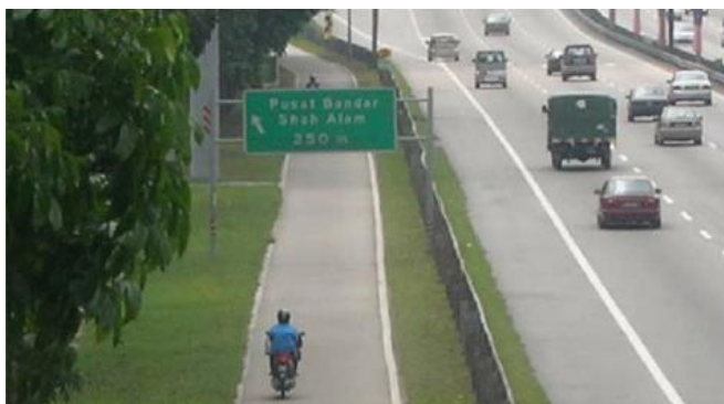
Figure 4.57: Voie réservée aux motocyclistes – Malaisie
