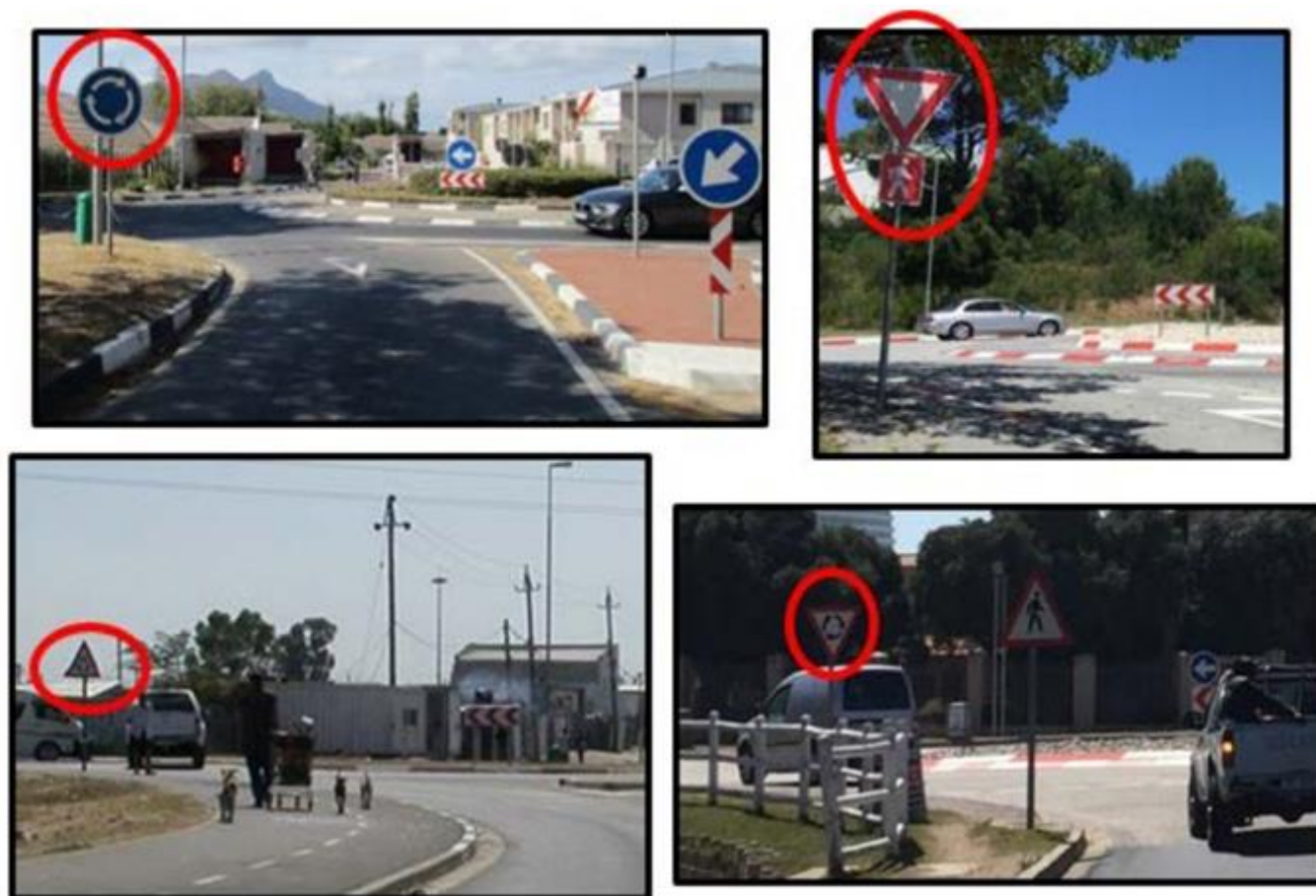
Figure 6.42: Panneau de bonne qualité pour les carrefours giratoires, mais la variation du panneau dans le même pays perturbe les conducteurs en Afrique du Sud.
