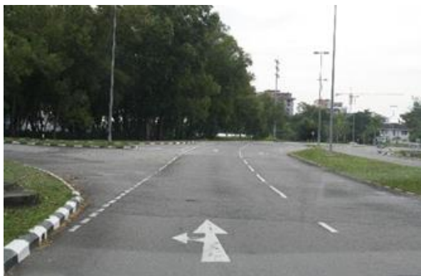
Figure 6.75: LILO urbain au Brunei avec un espace insuffisant pour un changement de voie en toute sécurité vers un virage à droite en dehors de la voie.
