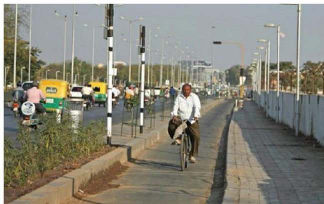
Figure 4.36: Couloir cyclable séparé sur une autoroute en Éthiopie.
