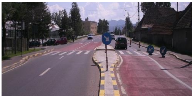
Figure 4.26: Peinture et rétrécissement à l'approche du passage piéton.
