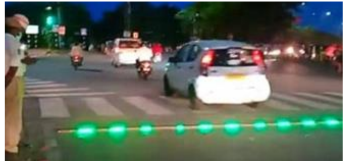
Figure 6.28: Dispositifs d'aide à la traversée des piétons (feux sur le passage piétons) à Hyderabad, Inde.
