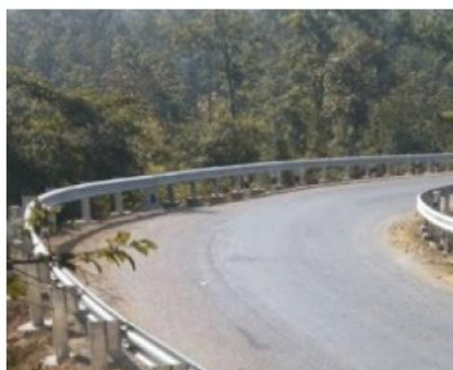
Figure 5.36: Glissière sem irigide sur une courbe horizontale au Népal.
