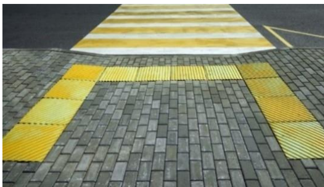
Figure 5.154: Bordure de trottoir abaissée aux deux extrémités du passage pour piétons avec revêtement tactile.
