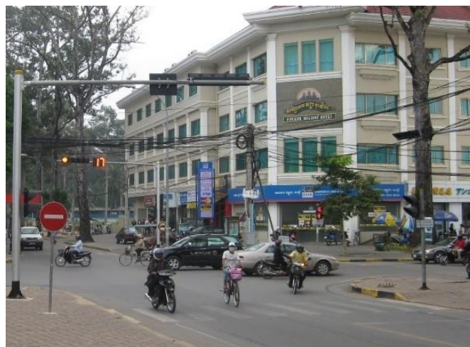
Figure 5.164: Marques de passage pour piétons défraîchies au Cambodge.
