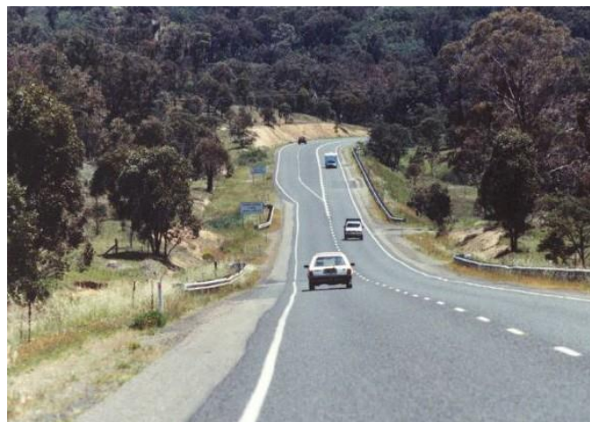
Figure 5.54: Exemple de voie de dépassement.
