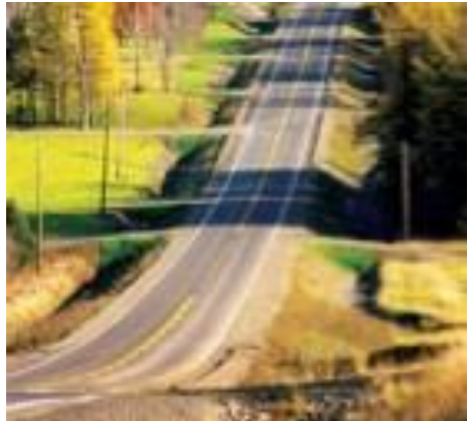
Figure 5.140: La combinaison des accès au bord de la route et des fossés de drainage profonds augmente le risque et la gravité potentielle des accidents.
