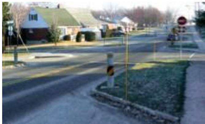
Figure 6.6: Panneaux d'arrêt avec mesures de ralentissement de la circulation à un carrefour sans feux de signalisation.
