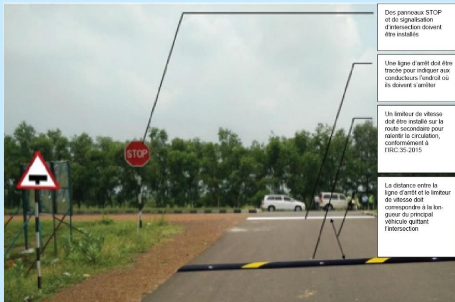
Figure 6.13: Traitement des routes secondaires ; ralentissement de la circulation et panneaux d'avertissement en Inde du point de vue d'une route principale.
