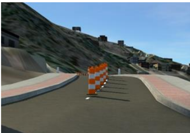
Figure 5.51: Illustration de la mise en place de bornes souples dans les courbes où la distance de visibilité est limitée.
