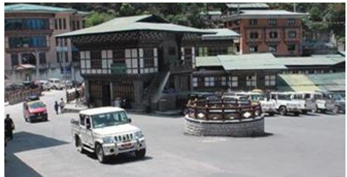
Figure 6.35: Emplacement et taille inappropriés des carrefours giratoires au Bhoutan.
