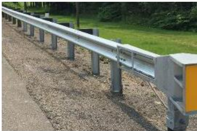
Figure 4.53: Glissière métallique typique.
