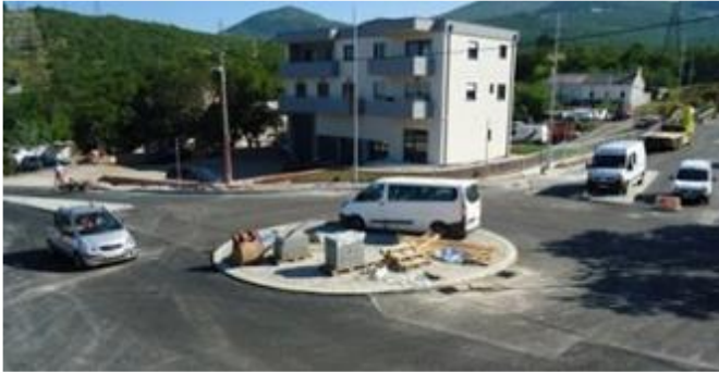
Figure 6.32: Véhicule ignorant un carrefour giratoire plat en Croatie
