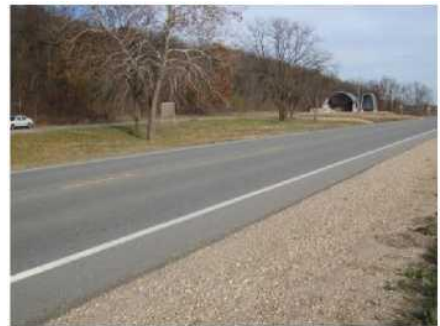
Figure 5.8: Accotement partiellement pavé ou composite
