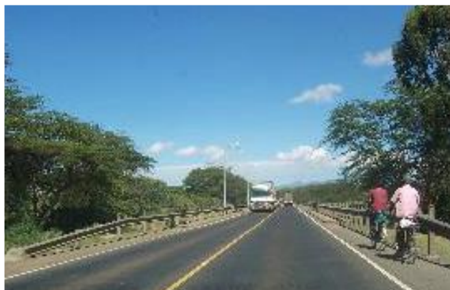
Figure 4.32: Cyclistes utilisant un accotement étroit – Rwanda.
