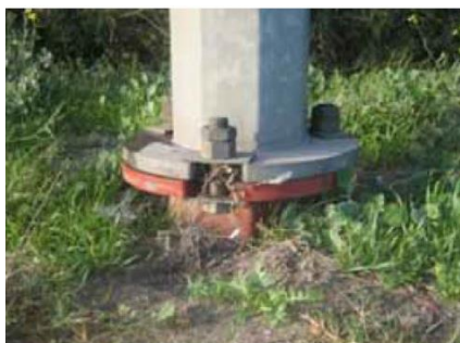
Figure 5.75: Colonne d'éclairage à patins adaptée aux routes à grande vitesse avec peu d'activité piétonne et de stationnement.
