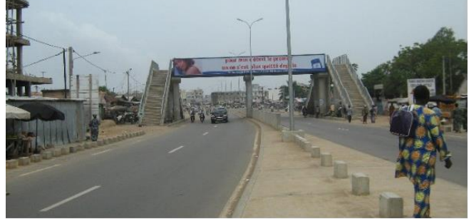
Figure 3.40: Habillage latéral opaque sur la passerelle pouvant dissuader les piétons d'utiliser l'infrastructure pour des raisons de sécurité
