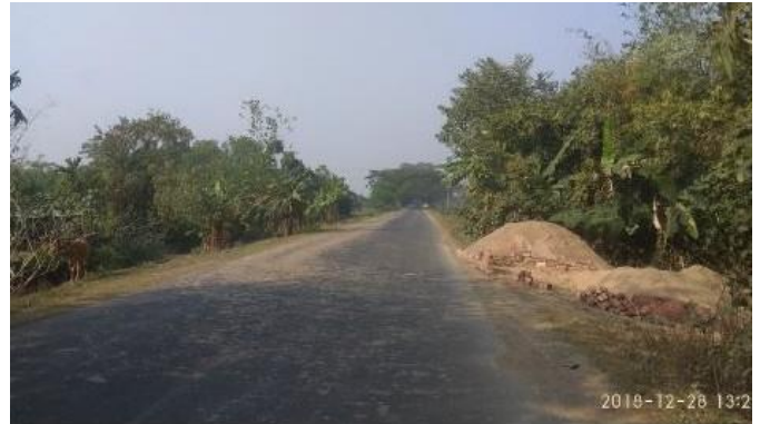
Figure 5.71: Matériaux empilés au bord de la route. Ils représentent un danger particulier pour les conducteurs de véhicules à deux ou trois roues, surtout la nuit.
