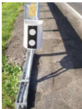
Figure 5.92: Borne entièrement re- directive, évasée ou tangentielle.
