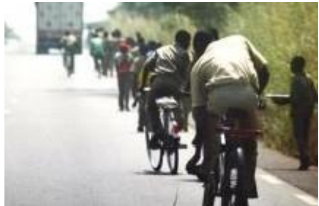
Figure 5.9: Les accotements étroits augmentent les risques pour les cyclistes sur la voie de circulation
