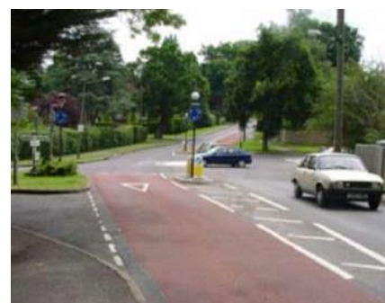
Figure 5.125: Revêtement à haut coefficient de frottement (coloré) appliqué à l'approche d'un mini carrefour giratoire.
