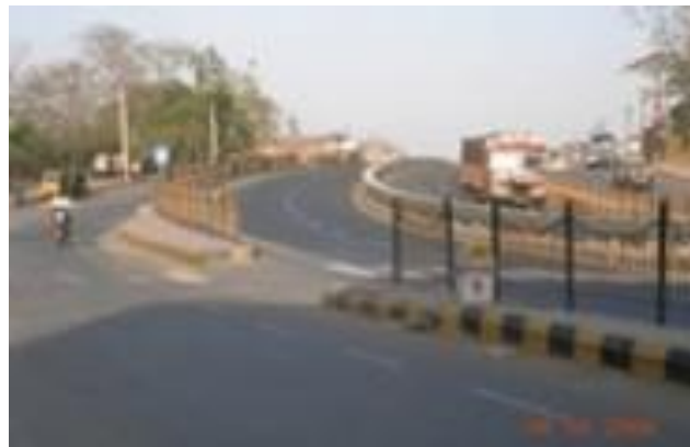
Figure 5.113: Utilisation d'un type de terre-plein central non standard et ouverture dangereuse du terre-plein central sur une route à grande vitesse.
