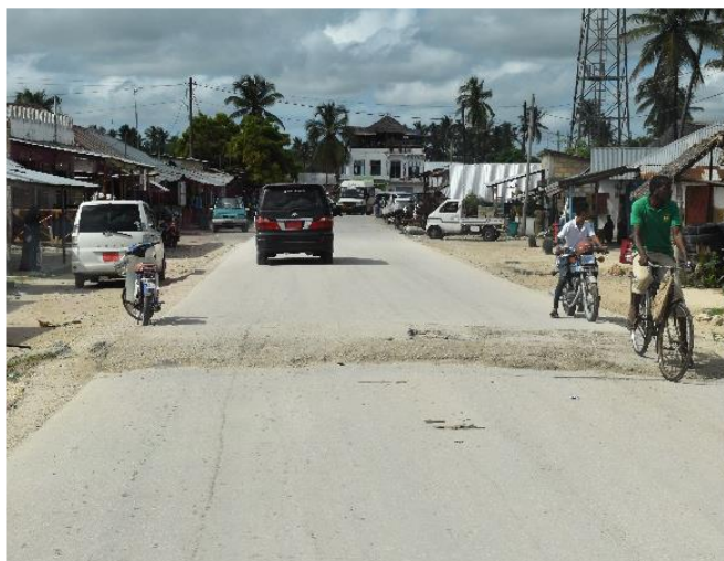
Figure 3.8: Ralentisseur non signalé (« invisible ») – Zanzibar.
