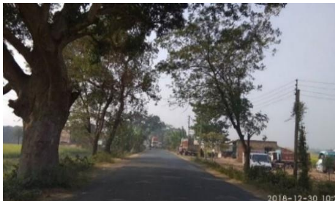
Figure 5.65: Arbres (plus de 100 mm de diamètre) situés trop près de la chaussée.
