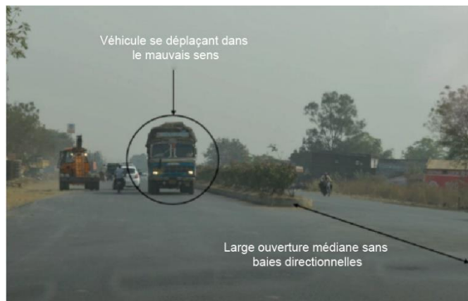
Figure 5.112: Ouverture dangereuse du terre-plein central entraînant une circulation en double sens.
