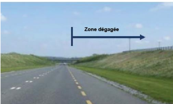
Figure 5.72: Exemple de zone dégagée.
