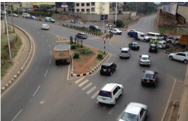
Figure 6.67: Voie d'accès à angle large avec des passages pour piétons mal alignés et l'absence de passage pour piétons.
