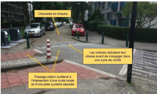
Figure 6.50: Carrefour surélevé avec différents types de chaussée.
