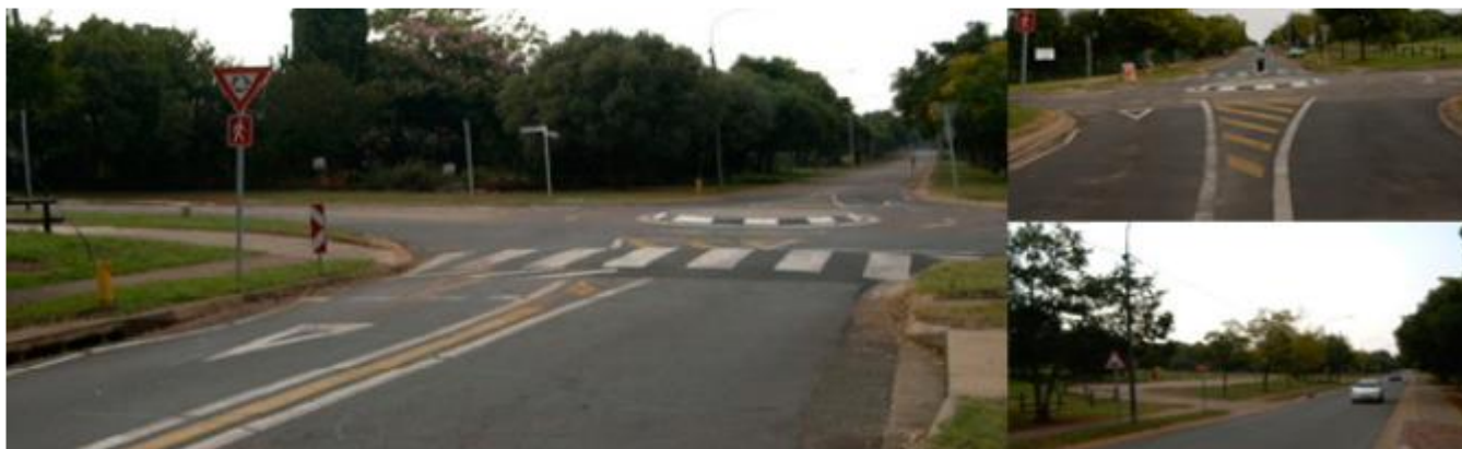
Figure 3.10: Passage piéton surélevé et cercle miniature
