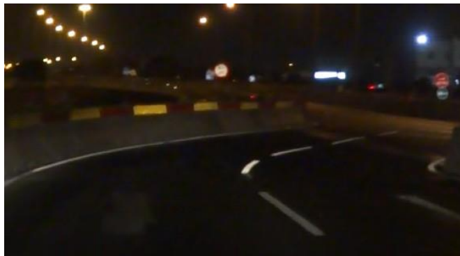
Figure 5.166: Marquage au sol éclairé par un matériau rétro-réfléchissant.
