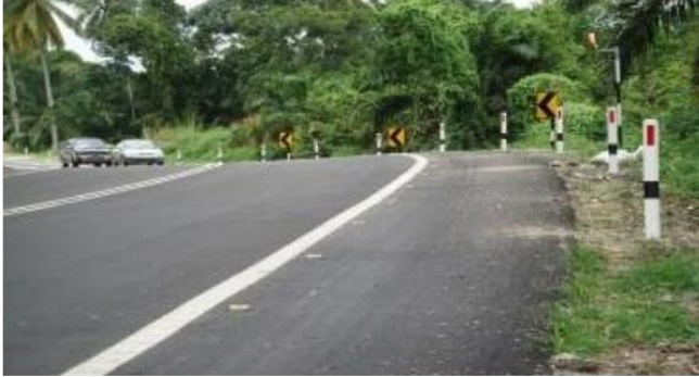
Figure 5.14: Large accotement revêtu dans le virage.
