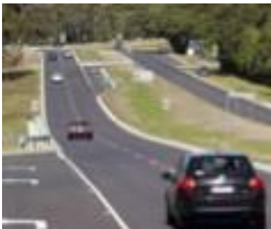
Figure 5.99: Terre-plein central engazonné avec bordure.
