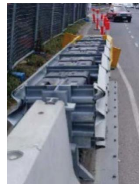
Figure 5.94: Amortisseur de sécurité à l'extrémité d'une glissière rigide sur un chantier de construction.
