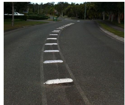
Figure 5.98: Terre-plein central avec barres de trottoir.
