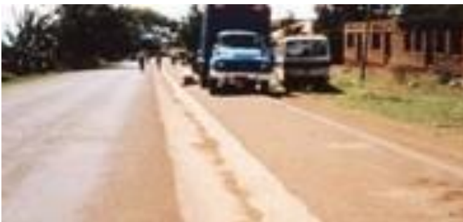
Figure 5.139: Drainage parabolique (bonne hydrodynamique, mais faible capacité).
