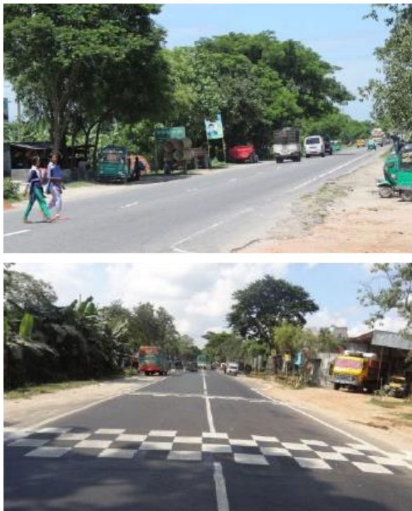
Figure 3.14: Installation d'un plateau ralentisseur avec marquage de damier. À gauche : avant l'intervention ; à droite : après l'intervention.
