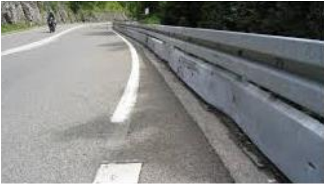
Figure 4.54: Une lisse-basse ajoutée à la glissière métallique au Vietnam.
