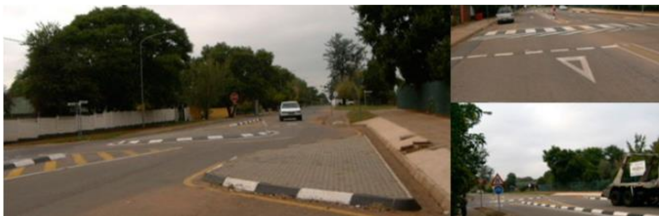
Figure 3.11: Utilisation d'infrastructures mixtes de ralentissement de la circulation – rétrécissements, ralentisseurs et délinéateurs
