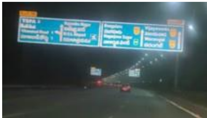
Figure 5.163: Voie rapide avec panneaux d'échange et éclairage à Hyderabad, en Inde.
