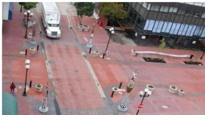
Figure 6.56: Carrefour marqué à faible coût.
