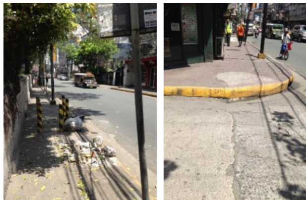
Figure 4.8: Voie piétonne obstruée et absence de bordure de trottoir à Manille.
