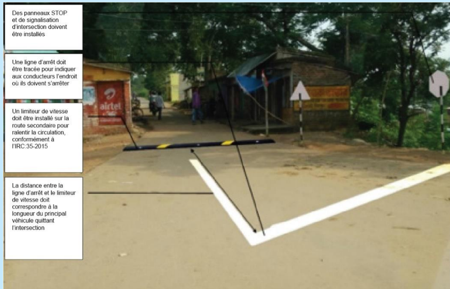
Figure 6.13: Traitement des routes secondaires ; ralentissement de la circulation et panneaux d'avertissement en Inde du point de vue d'une route principale.
