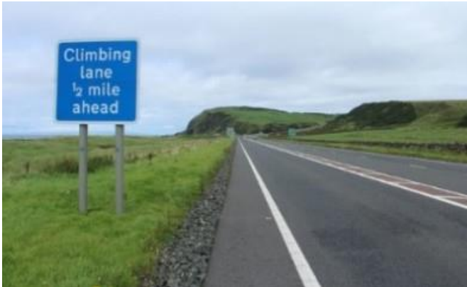
Figure 5.57: Exemple de signalisation préalable d'une voie en montée.
