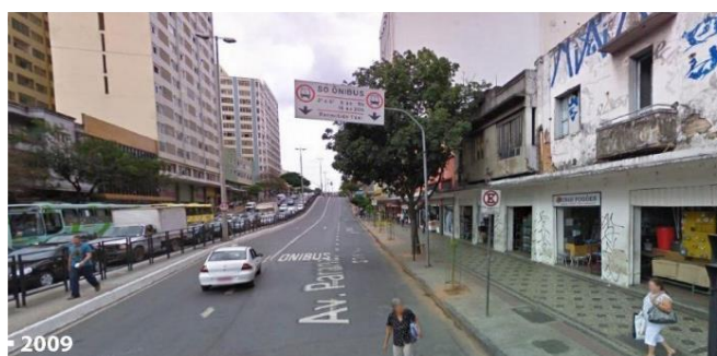
Figure 5.4: Exemple d'un aménagement routier au Brésil montrant la réduction du nombre de voies de trois voies en 2009 à deux voies en 2014, avec l'ajout d'une voie piétonne centrale et de bandes cyclables.
