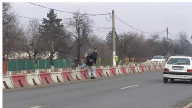
Figure 3.26: Terre-plein central mal conçu, sans endroit pour traverser – Roumanie.
