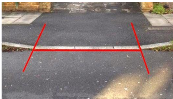
Figure 5.156: Bordure de trottoir abaissée permettant d'accéder à la propriété.
