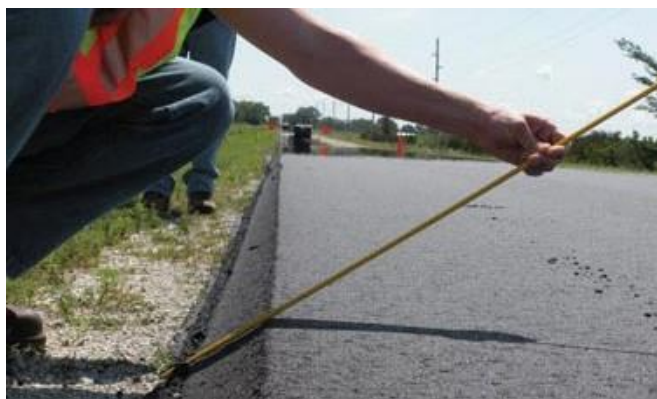
Figure 5.30: Bordure de sécurité. Après l'installation de la bordure de sécurité, le matériau non revêtu adjacent doit être nivelé pour l'aligner sur le dessus de la chaussée.
