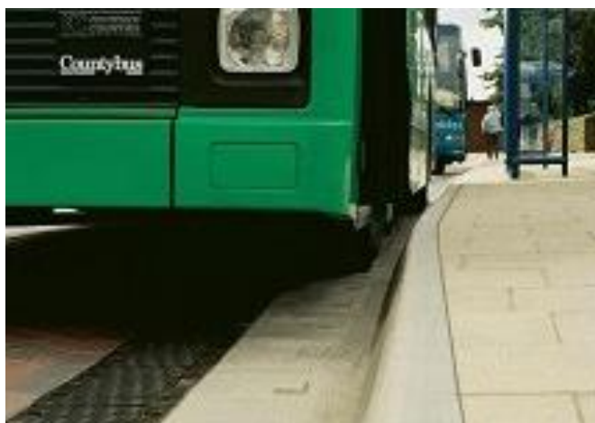
• Figure 5.155: Bordure d'arrêt de bus pour faciliter l'accès des passagers.
