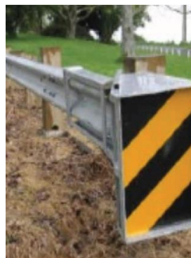
Figure 5.93 : Borne évasée à absorption d'énergie.
