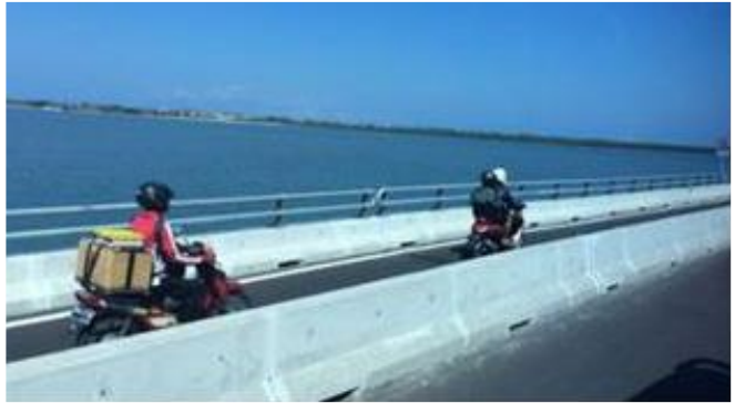
Figure 4.55: Voie séparée par une glissière en béton pour les motocyclistes en Indonésie.
