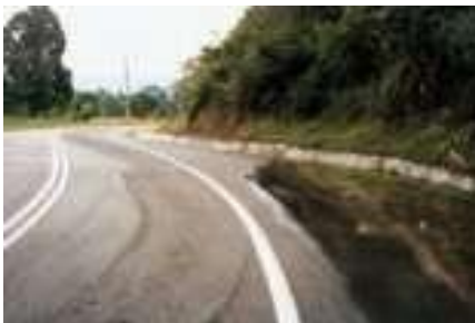
Figure 5.129: Large accotement revêtu et dispositif de drainage sur une pente descendante.
