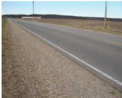
Figure 5.7: Accotement en gravier non revêtu.
