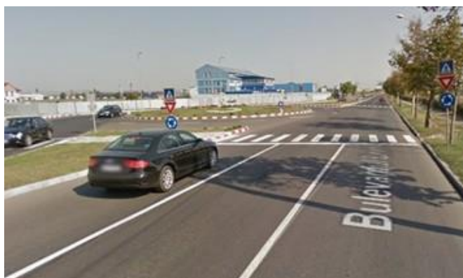
Figure 6.31: Conception dangereuse d'un carrefour giratoire en Roumanie, où la route principale n'a pas de déviation.
