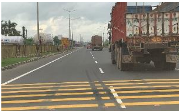
Figure 3.4: Bandes rugueuses sur l'autoroute.
