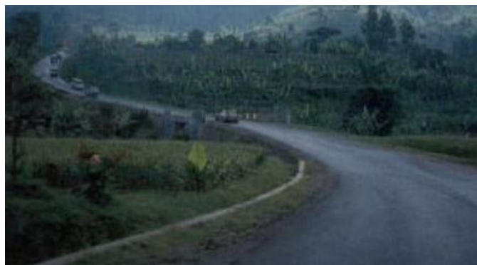
Figure 5.22: Exemple de bonne combinaison de courbes horizontales et verticales offrant une bonne visibilité.
