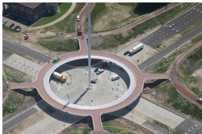
Figure 4.45: Carrefour giratoire suspendu pour cyclistes – Pays-Bas.
