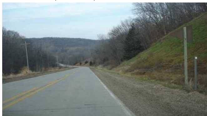
Figure 5.19: Combinaison dangereuse d'une courbe horizontale au pied d'une pente raide.
