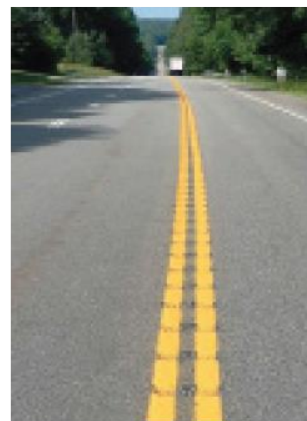
Figure 5.34: Bandes rugueuses sur la ligne médiane par fraisage de la route.
