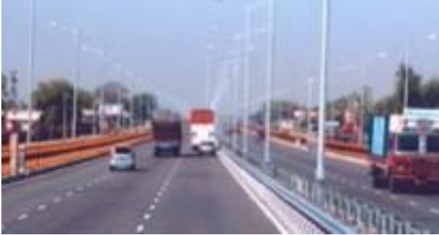
Figure 5.102: Glissière centrale semi-rigide sur voie rapide.
