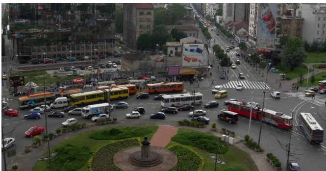
Figure 6.39: Carrefour giratoire (rotatif) dont l'alignement et la largeur des voies ne sont pas corrects, créant ainsi des voies supplémentaires en Serbie.
