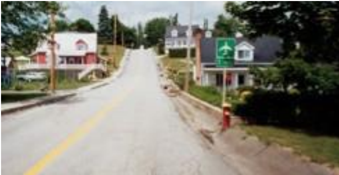
Figure 5.138: Dispositif de drainage dangereux sur une route étroite et vallonnée.
