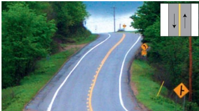
Figure 5.27: Courbe horizontale au pied d'une pente raide avec signalisation avancée.
