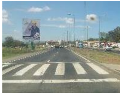
Figure 4.21: Passage piéton surélevé pour ralentir les vitesses d'approche – Kenya.
