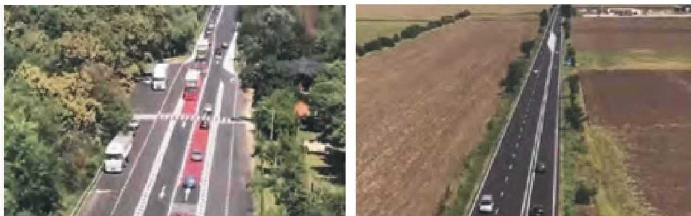
Figure 5.61: Programme pilote de modernisation de la route nationale roumaine 2 (DN2) en 2019.
