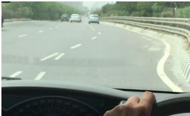
Figure 5.165: Déviation inattendue du marquage au sol : Inde
