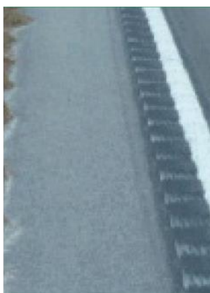
Figure 5.33: Bande rugueuse en bordure de route par fraisage de la route.
