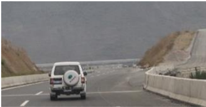
Figure 5.44: Rampe d'évacuation (en construction) en Chine.
