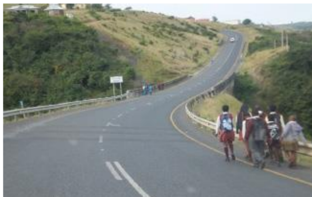
Figure 4.11: Voie piétonne non protégée sur une route nationale rurale.
