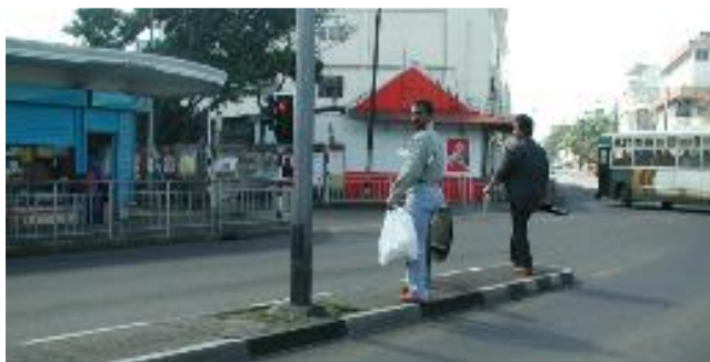
Figure 4.25: Manque d'espace pour les piétons sur le terre-plein central – Maurice – inspection de sécurité.
