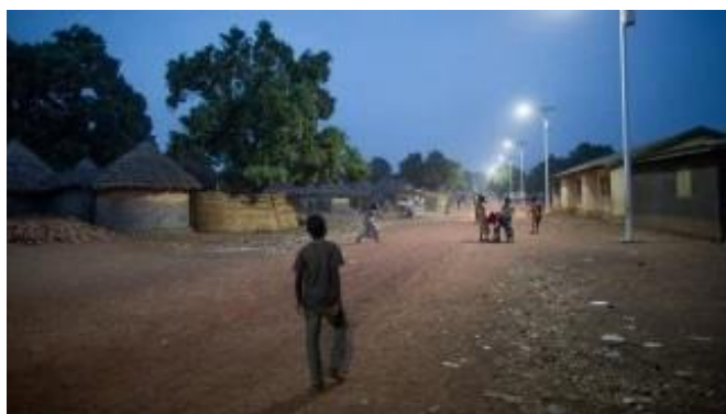
Figure 5.168: Éclairage public à énergie solaire,
