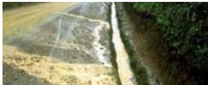
Figure 5.143: Protection des fossés avec de la végétation, des rochers, de la maçonnerie ou du béton pour résister à l'érosion des fossés.
