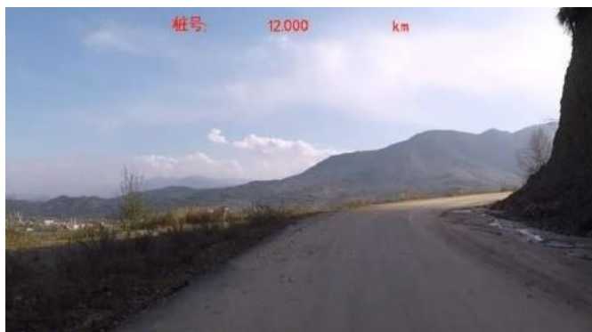
Figure 5.18: Délimitation insuffisante de la courbe.
