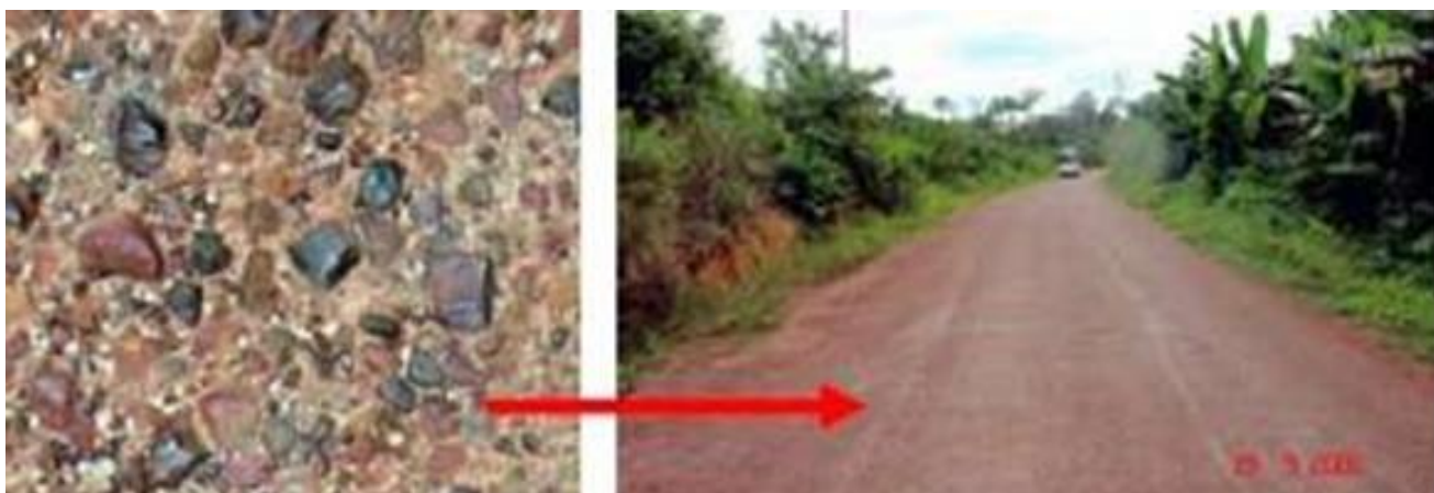
Figure 5.122: Enduit de surface Otta sur une route à faible trafic en bon état avec des résultats satisfaisants. (Image de gauche : gros plan de l'enduit de surface Otta.)
