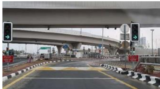
Figure 6.86: Passage à niveau contrôlé par signal automatique ; tramway de Dubaï.
