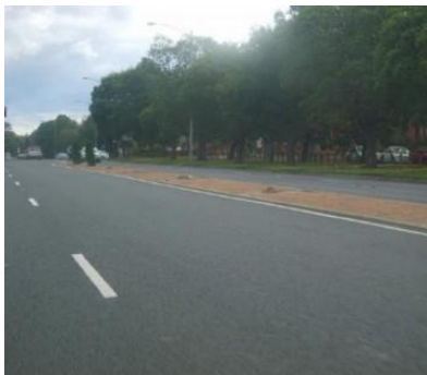
Figure 5.100: Terre-plein central à bordure.
