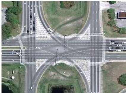
Figure 6.64: Grand carrefour urbain avec marquage de la chaussée pour les mouvements de virage.
