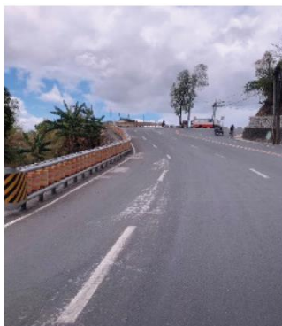
Figure 5.91: Amortisseur de choc entièrement redirectif – Philippines
