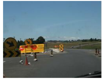
Figure 3.45: Site bien signalisé et contrôlé – Tanzanie
