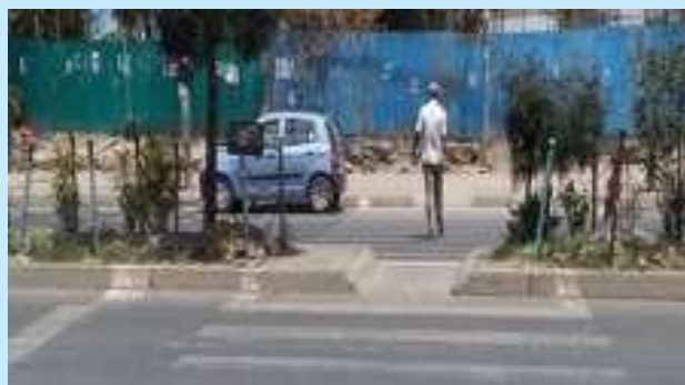
Figure 5.119: Ouverture du terre-plein central pour les piétons
