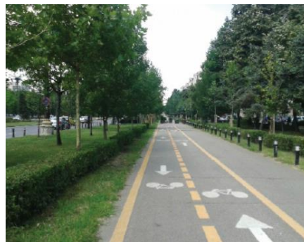
Figure 4.39: Bande cyclable séparée de la circulation des véhicules sur la route principale – Bucarest, Roumanie.
