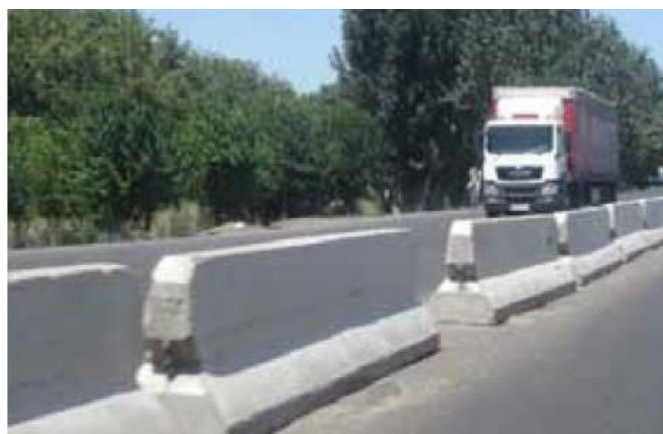
Figure 5.69: Blocs de béton individuels.
