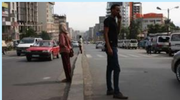
Figure 5.117: Terre-plein central étroit et dangereux
