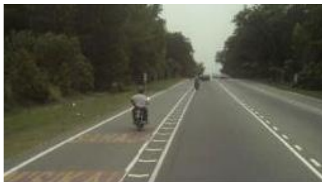
Figure 4.58: Voie réservée aux motocyclistes – Malaisie.
