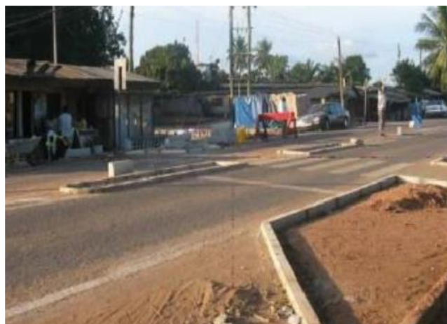
Figure 3.3: Rétrécissement de la route avec des îlots de circulation et des bordures prolongées.
