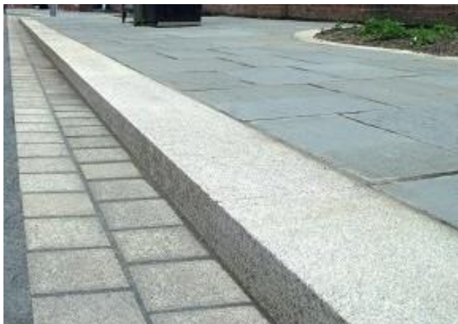
Figure 5.153: Bordure de trottoir verticale adjacente à la voie piétonne.
