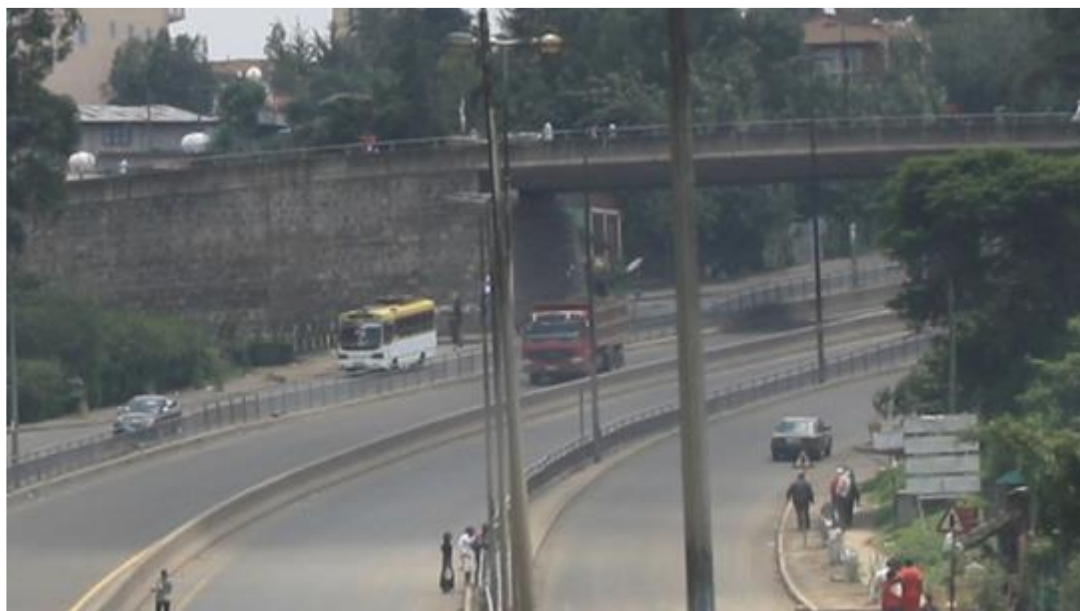
Figure 6.82: Un simple passage supérieur sans connexion entre les deux routes en Éthiopie.
