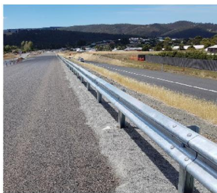
Figure 5.81: Glissière semi-rigide (poutre en W).
