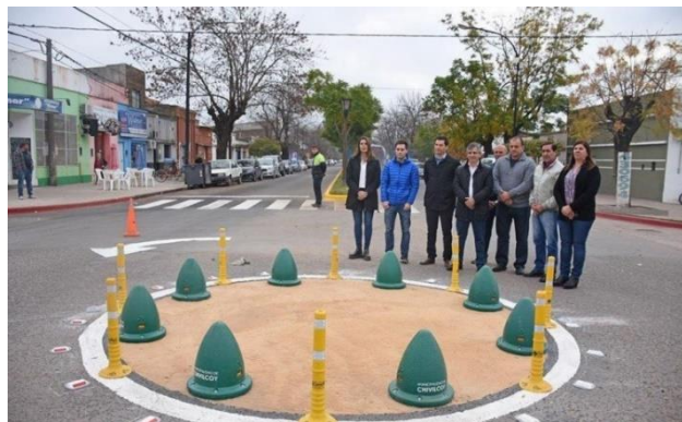
Figure 6.46: Exemple de carrefour giratoire à faible coût en Argentine
