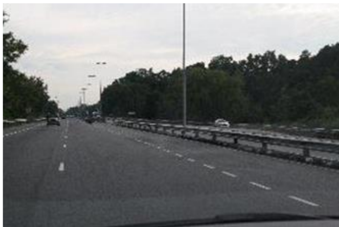
Figure 6.80: Voie de déviation en dehors de la chaussée au Brunei: terre-plein central étroit et voie nécessitant un espace supplémentaire au-delà du virage.
