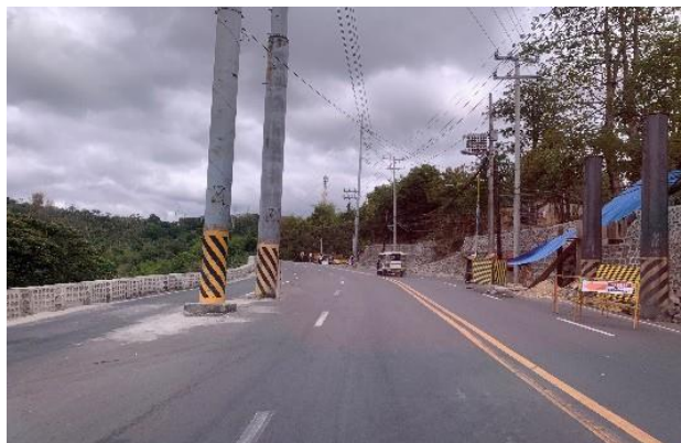
Figure 5.63: Route élargie, mais sans déplacer les poteaux – Philippines.
