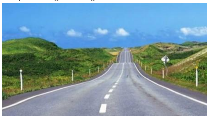
Figure 5.20: Mauvaise combinaison d'alignement montrant des ruptures optiques causées par des courbes rentrantes abruptes le long de la tangente horizontale.
