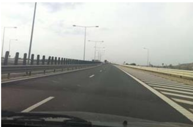
Figure 5.116: Glissière anti-éblouissement sur le dessus du terre-plein central.
