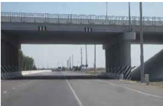
Figure 5.68: Piliers de passage supérieur non blindés.
