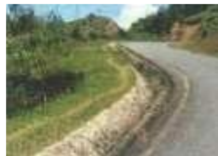
Figure 5.128: Drainage conventionnel en forme de V.
