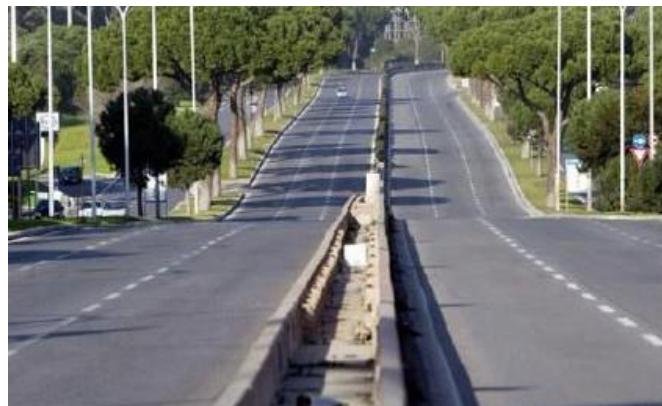
Figure 5.149: Bordures de trottoir verticales dangereuses sur une route à grande vitesse.
