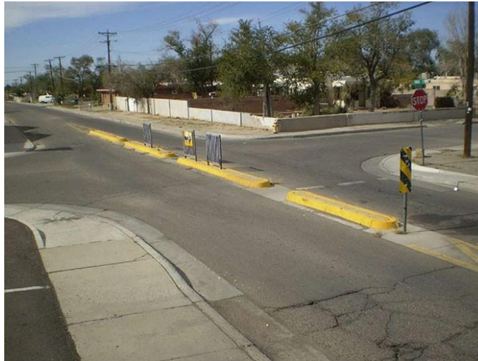
Figura A.6: Mediana estrecha que impide los giros en la intersección. (Fuente: FHWA)
