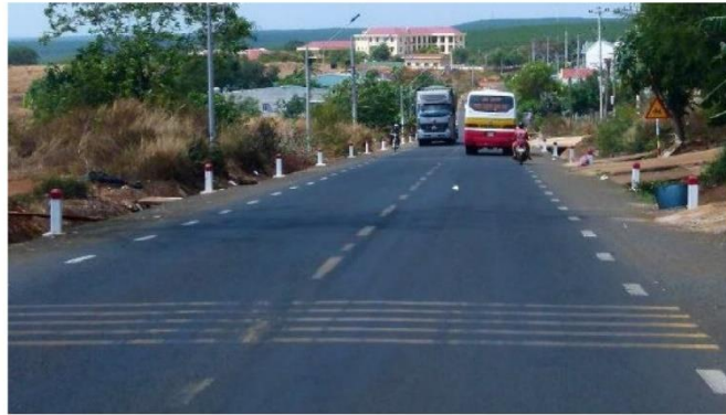
Figura A.12: Ejemplo de bandas sonoras transversales ATLM en Vietnam. (Fuente: Banco Mundial)
