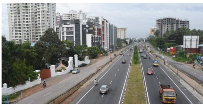
Figura A.4: Mediana construida en carretera de alta velocidad (Fuente: B P Deepu, EPS)
