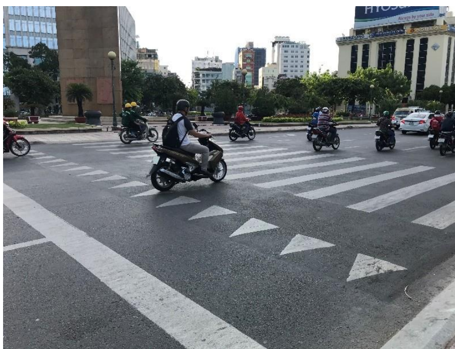
Figura A.16: Paso de peatones elevado (Fuente: GRSF)
