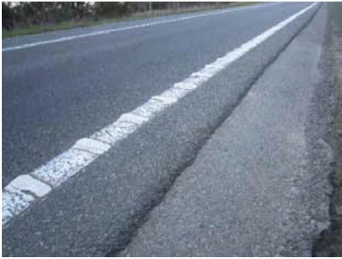
Figura A.11: Ejemplo de ATLM longitudinal (Fuente: Secretaría CAREC 2018. Manual de ingeniería de seguridad vial CAREC 2: Obras viales más seguras)
