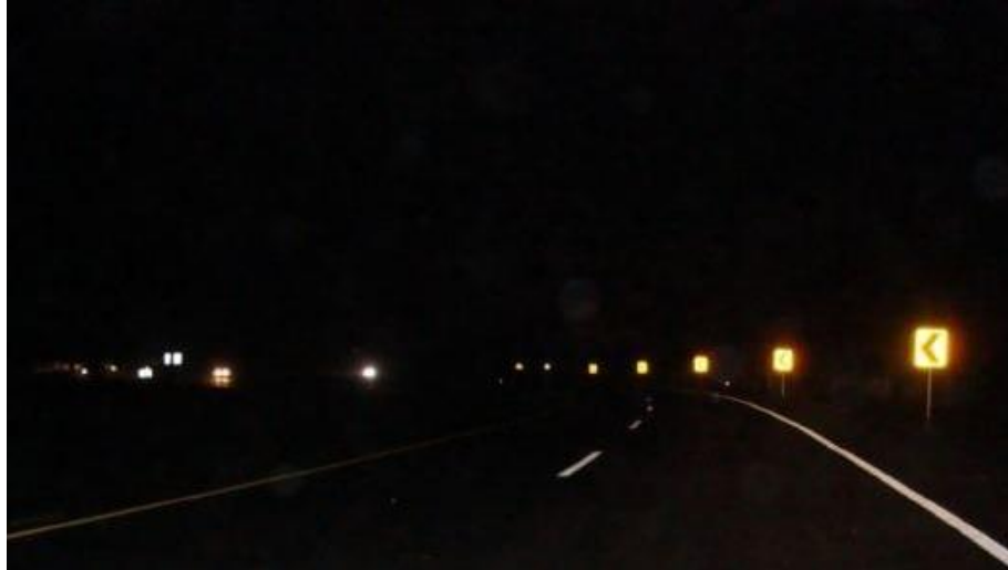
Figura A.10: Ejemplo de señalización y/o marcado de líneas Señales tipo chevrón retrorreflectantes que proporcionan visibilidad nocturna. (Fuente: iRAP)
