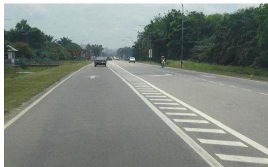
Figura A.5: Mediana pintada/eclosión central. (Fuente: iRAP)
