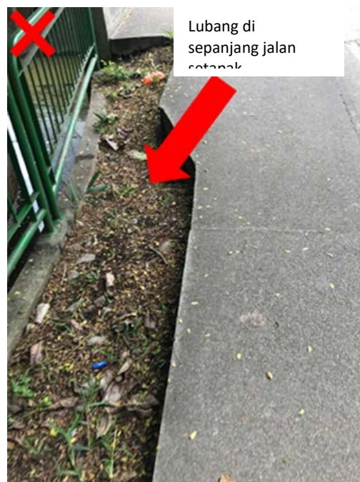
Foto 5.6. Jalan Setapak Berbahaya, Singapura
