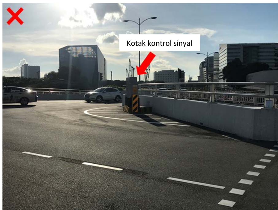
Foto 5.2. Kotak sinyal terletak tidak aman di tepi jalan raya, Singapura
