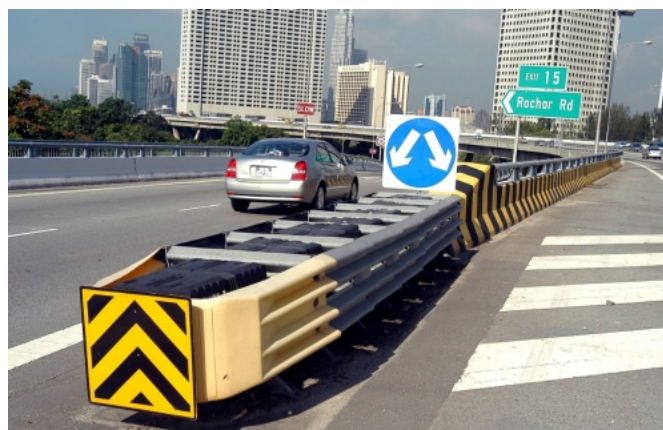
รูปที่ 4.1 อุปกรณ์ดูดซับแรงกระแทก สิงคโปร์
