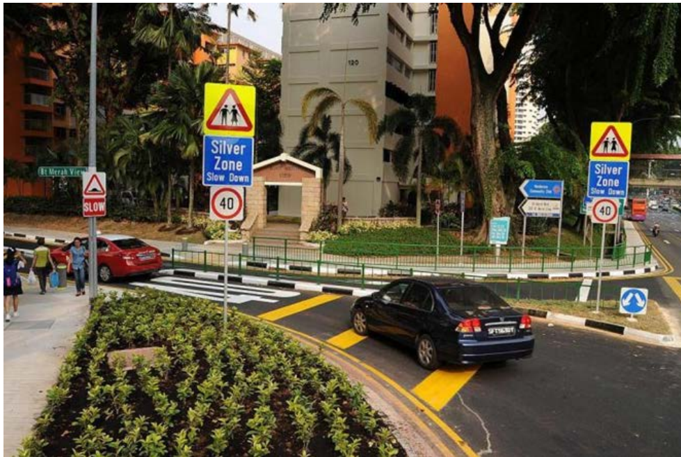
Hình 3.2. Biển báo và dải gậy ôn tại Khu vực có nhiều người cao tuổi - Bukit Merah View 8
