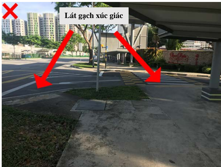
Hình 5.4. Lối băng qua đường chưa được dỡ bỏ hoàn toàn - Singapore
