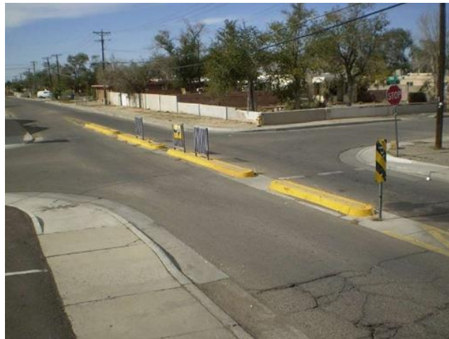
Figura A.6: Canteiro central estreito impedindo movimentos de conversão no cruzamento. (Fonte: FHWA)
