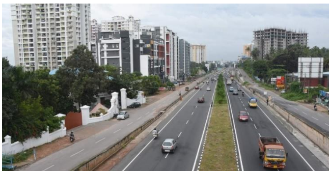
Figura A.4: Canteiro central construído em via de alta velocidade (Fonte: B P Deepu, EPS)
