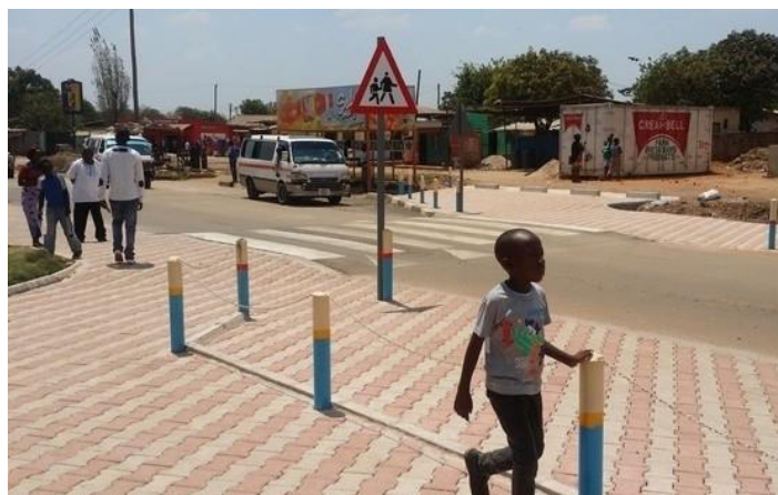
Figura A.8: Faixa de pedestres incorporando dispositivos para redução da velocidade. (Fonte: Lusakatimes , 2019)
