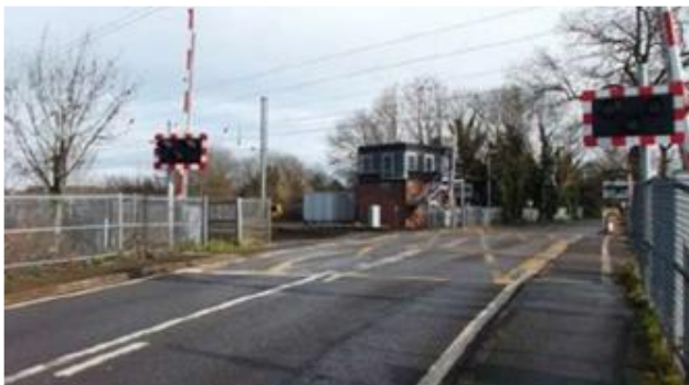
Figura 6.85: Cruzamento ferroviário no Reino Unido
