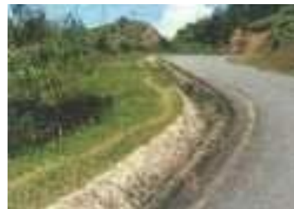
Figura 5.128: Drenagem convencional em forma de V.
