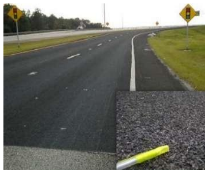
Figura 5.123: Tratamento do pavimento da superfície, com material de permite um elevado atrito, em curva perigosa.
