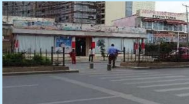
Figura 5.118: Ampla abertura central com postes de concreto.
