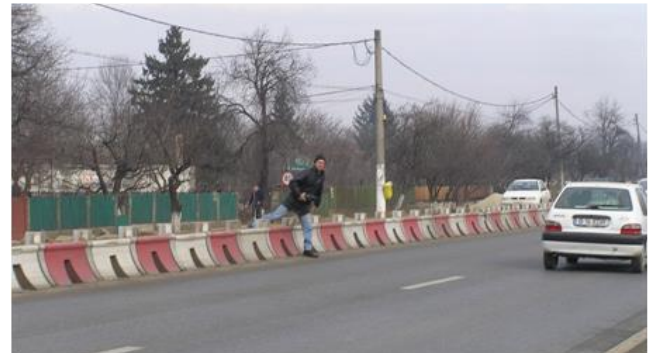
Figura 3.26: Canteiro central mal concebido para impedir a travessia de pedestres – Romênia.
