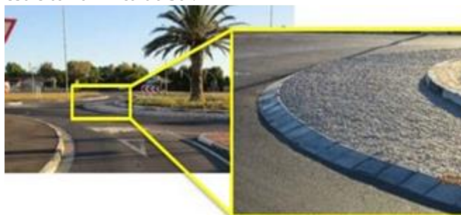
Figura 6.37: Pátio para caminhão com traçado correto para uso somente por caminhões - com vagão circular estreito na África do Sul.
