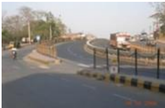
Figura 5.113: Instalação de um canteiro central fora do padrão, que contém uma abertura insegura, em uma estrada de alta velocidade.
