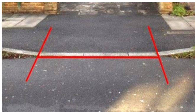
Figura 5.156: Meio-fio rebaixado para acesso à propriedade.
