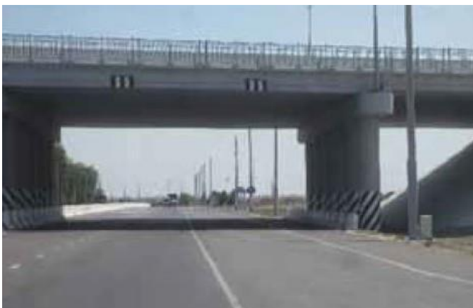
Figura 5.68: Pilares de viadutos não blindados.
