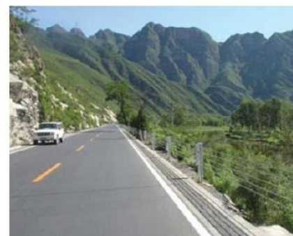
Figura 5.37: Barreira com cabos de aço na seção tangente.
