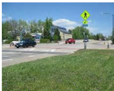
Figura 6.53: Cruzamento elevado e com sinalização para travessia.
