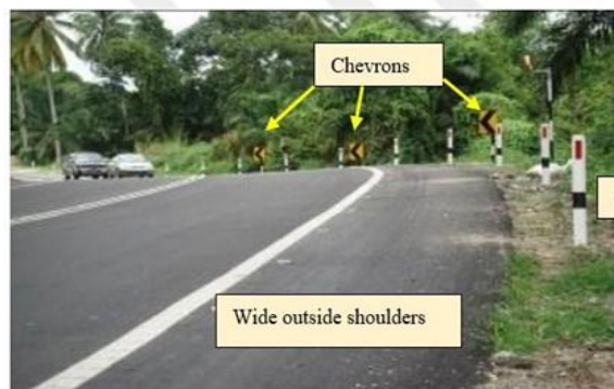
Figura 5.28: Exemplo de melhoria de curva na Malásia.
