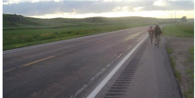
Figura 5.15: Acostamento pavimentado com faixas de vibração, utilizado por ciclistas.
