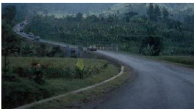
Figura 5.22: Exemplo de boa combinação de curvatura horizontal e vertical proporcionando boa visibilidade.
