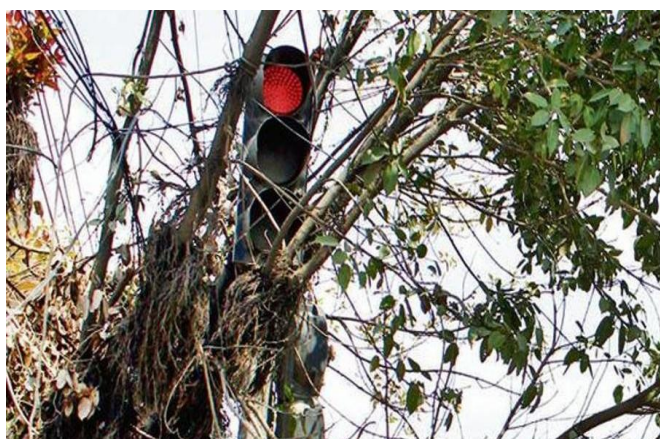
Figura 6.18: Semáforo escondido pelos galhos de uma árvore em Gurudwara, Índia; árvores/galhos devem ser removidos ou o semáforo deve ser substituído.
