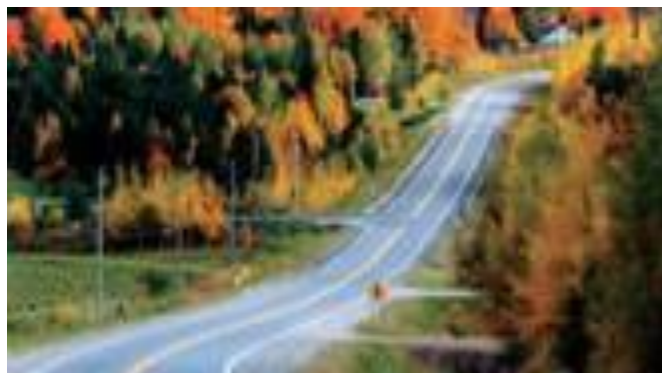
Figura 5.21: Combinação perigosa: curva no cume da colina, antes de uma curva horizontal acentuada, que contém cruzamentos e acessos.
