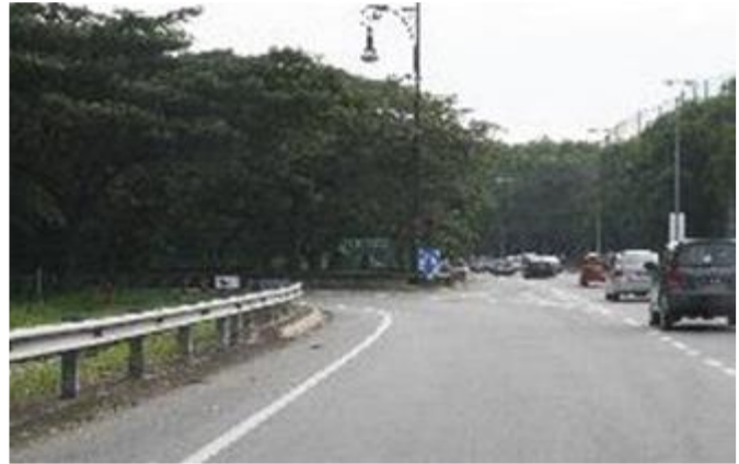
Figura 6.78: Raio de saída apertado para aproximação da faixa de desaceleração – Brunei.
