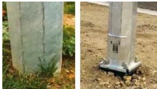
Figura 5.170: Colunas de iluminação com absorção de impacto adequadas para ambientes de baixa velocidade com maior atividade de pedestres e estacionamento.
