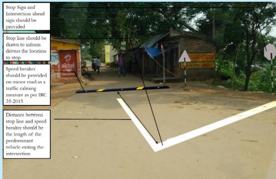
Figura 6.13: Pequenas intervenções: desaceleração da velocidade do trânsito e sinais de alerta na Índia, sob a perspectiva de uma estrada principal.
