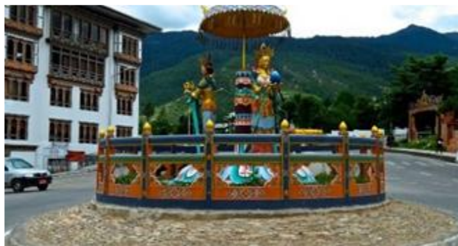
Figura 6.33: Rotatória decorada que obscurece a visão do condutor no Butão
