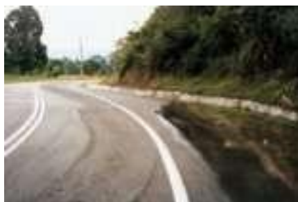
Figura 5.129: Acostamento largo pavimentado e instalação de drenagem em declive.
