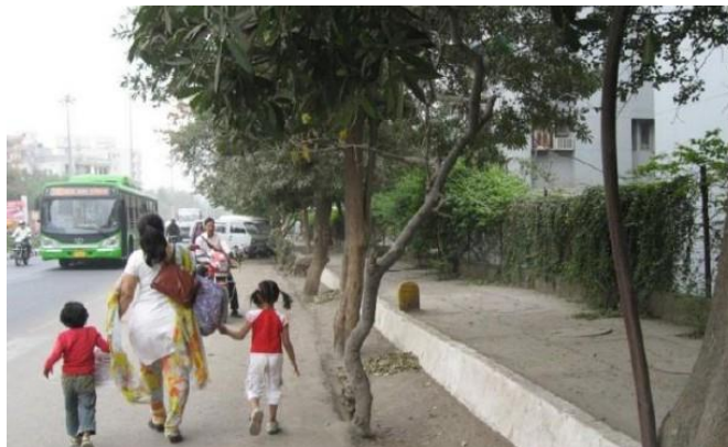
Figura 5.151: Meio-fio muito alto (aprox. 250 mm) limitando o acesso de pedestres à calçada
