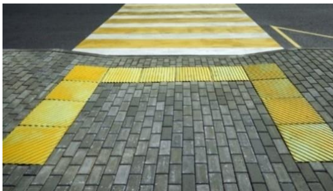
Figura 5.154: Meio-fio rebaixado em ambas as extremidades da faixa de pedestres com piso tátil.
