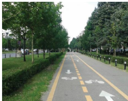
Figura 4.39: Ciclovia separada do tráfego de veículos da rodovia – Bucareste, Romênia.
