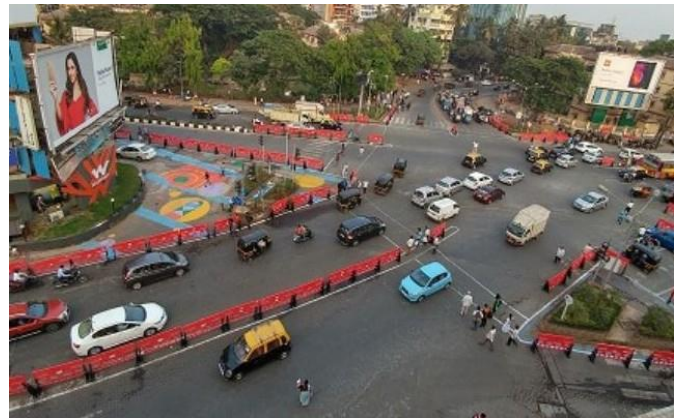
Figura 2.27: Intervenções temporárias de baixo custo implementadas (utilizando tinta, giz e barricadas) durante o ensaio (abril de 2017).
