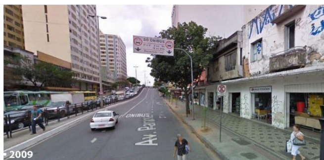
Figura 5.4: Exemplo de uma “dieta rodoviária” no Brasil mostrando redução no número de faixas de três em cada sentido em 2009 para duas em cada sentido em 2014, com a adição de uma ampla faixa central para pedestres e ciclovias.
