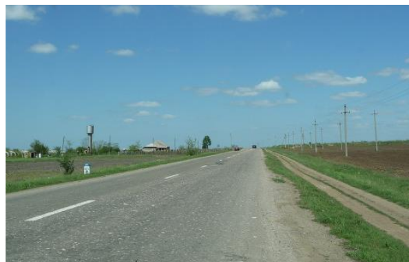
Figura 3.32: Moldávia – via de serviço para veículos lentos.
