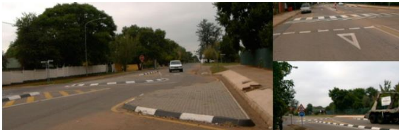
Figura 3.11: Utilização de infraestruturas mistas para desaceleração do tráfego – estreitamentos, lombadas e delineadores
