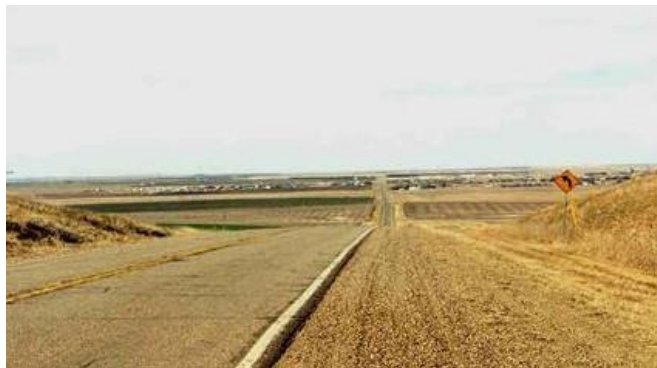
Figura 5.41: Redução do campo de visão em uma curva vertical convexa (sag vertical curve).
