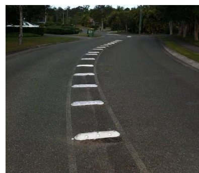
Figura 5.98: Canteiro central com barras no pavimento. (pavement bars).
