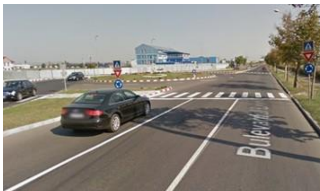
Figura 6.31: Projeto de rotatória perigosa na Roménia, onde a estrada principal não tem desvio.
