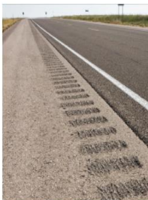
Figura 5.31: Faixa de vibração no acostamento.
