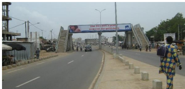
Figura 3.40: A lateral opaca da passarela pode impedir que os pedestres utilizem a instalação, devido a questões de segurança
