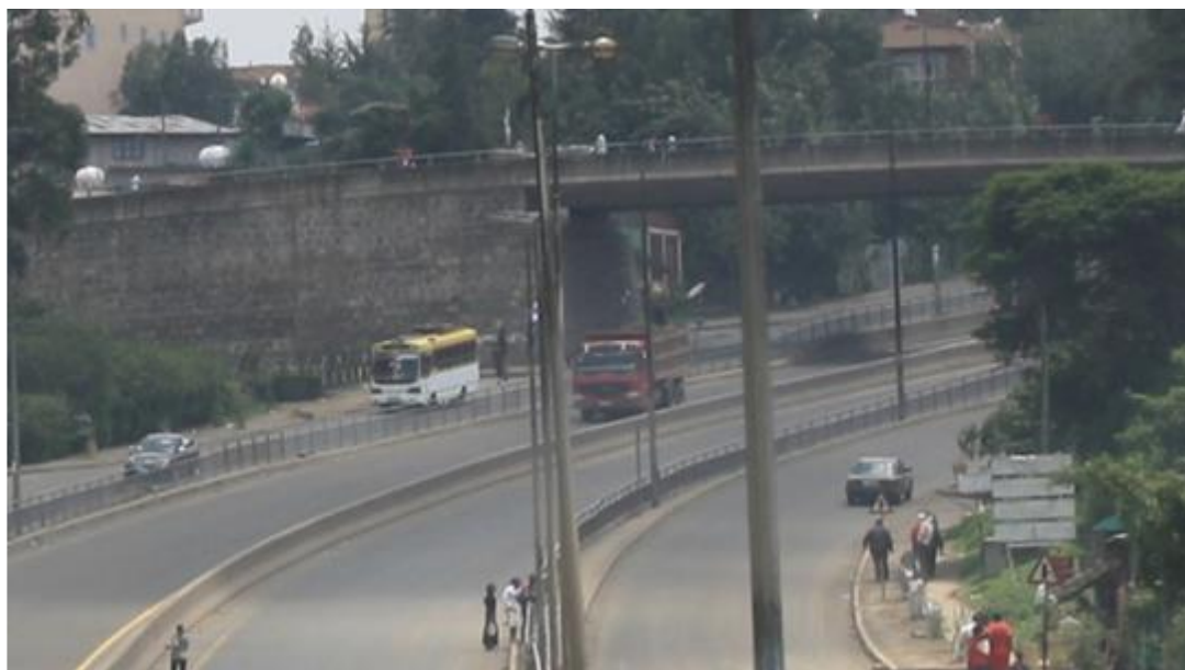
Figura 6.82: Um viaduto simples sem ligação entre as duas rotas – Etiópia.
