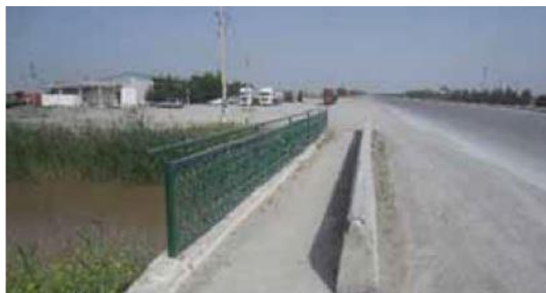
Figura 5.86: Trilhos leves com meio-fio de concreto.
