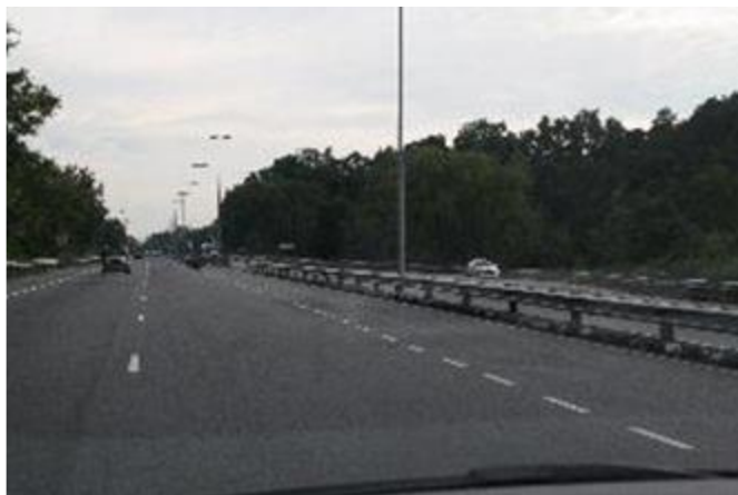
Figura 6.80: Faixa de desvio externa – Brunei – canteiro central estreito e faixa que requer espaço adicional além da curva.
