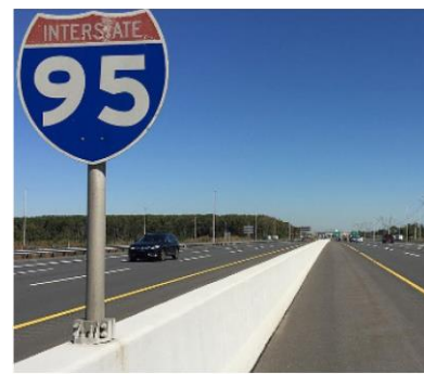
Figura 5.82: Barreira rígida (perfil F).
