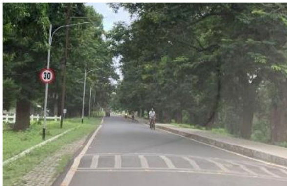
Figura 3.33: Sinalização de velocidade e lombada para tratamento de porta de entrada (Gateway) na Índia.
