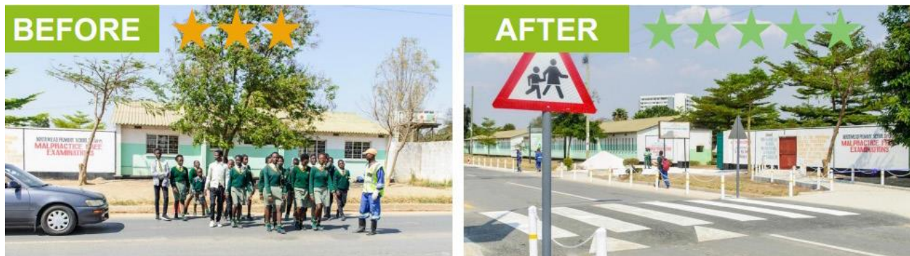
Figura 4.29: Instalação de travessia elevada com sinalização e calçada protegida – Zâmbia
