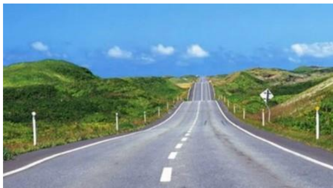
Figura 5.20: Combinação de alinhamento ruim mostrando quebras ópticas causadas por curvas acentuadas ao longo da tangente horizontal.
