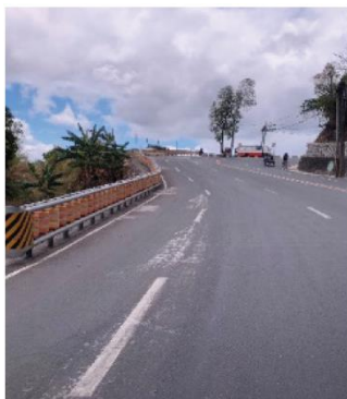
Figura 5.91: Amortecimento de colisão totalmente redirecionado – Filipinas.
