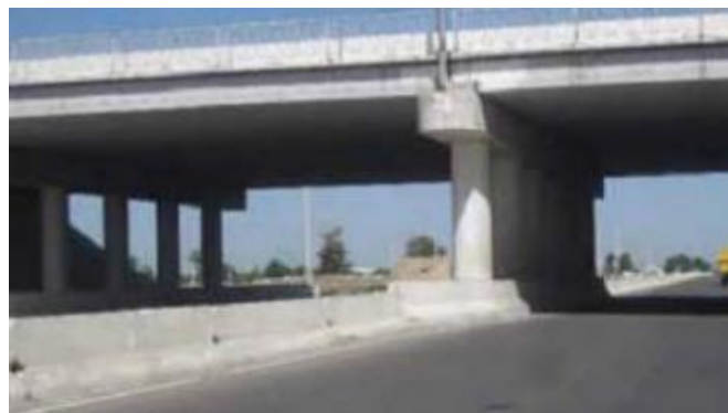
Figura 5.77: Pilares blindados com barreiras rígidas. Um tratamento final apropriado (almofadas/atenuadores de impacto) também deve ser aplicado em sistemas de barreira.
