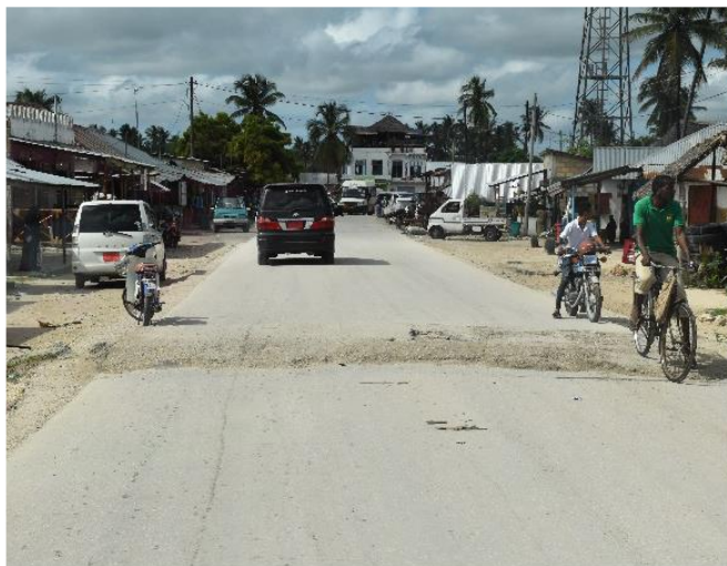
Figura 3.8: Lombada para redução da velocidade não sinalizada ("invisível") – Zanzibar.
