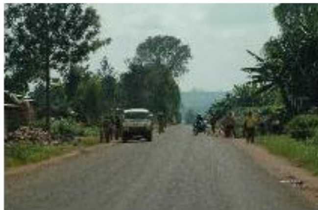
Figura 4.66: Ponto de ônibus numa aldeia rural, sem sinalização ou instalações - Burundi.
