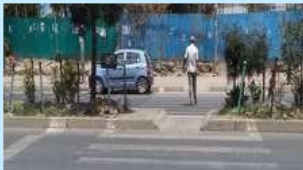
Figura 5.119: Ouverture du terre-plein central pour les piétons
