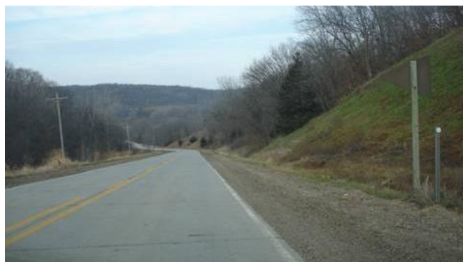
Figura 5.19: Combinação perigosa de curva horizontal na base de uma elevação íngreme.
