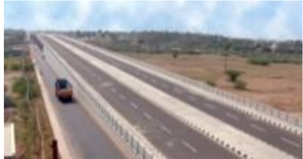
Figura 5.103: Canteiro central elevado em faixa de rodagem dupla.
