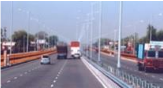
Figura 5.102: Barreira central semirrígida em via expressa.
