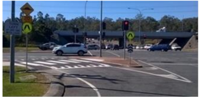
Figura 6.69: Faixa de pedestres com elevação e acesso contendo marcações de “ilha fantasma” e sinalização de faixa de pedestres.
