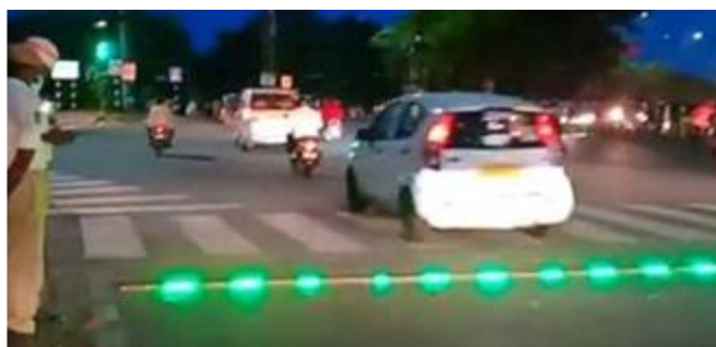
Figura 6.28: Dispositivos para assistência aos pedestres (sinais na travessia) em Hyderabad, Índia.
