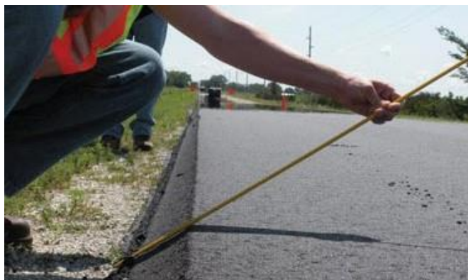
Figura 5.30: Borda de segurança. Depois de instalar a borda de segurança, o material não pavimentado adjacente à borda deve ser nivelado com o topo do pavimento.
