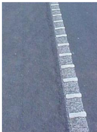
Figura 5.32: Linha de borda com nervuras.
