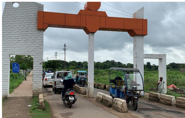
Figura 3.34: Intervenções na porta de entrada (Gateway) na Índia.
