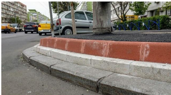
Figura 5.152: Meio-fio triplo em Bucareste, limitando o acesso de pedestres.
