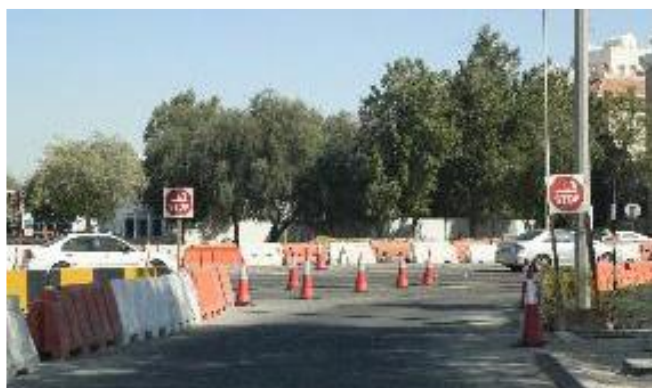
Figura 3.47: Zona de trabalho bem sinalizada e protegida – Abu Dhabi.
