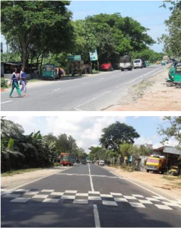
Figura 3.14: Instalação da faixa para diminuição da velocidade com marcação quadriculada. Esquerda: antes da intervenção; Direita: Após a intervenção.
