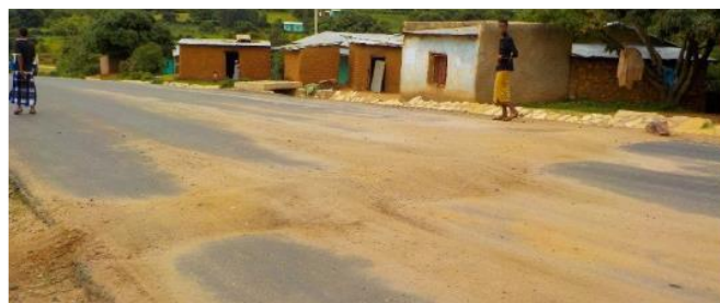
Figura 3.5: Lombada colocada pela comunidade na via que passa pela aldeia – Etiópia.
