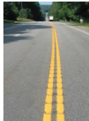
Figura 5.34: Faixas de vibração da linha central por fresamento de estrada.
