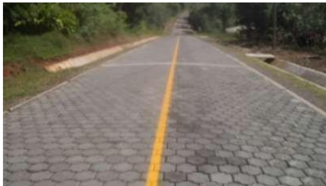
Figura 5.121: Blocos de concreto (paralelepípedos) pavimentando a via apropriadamente e oferecendo a drenagem adequada.
