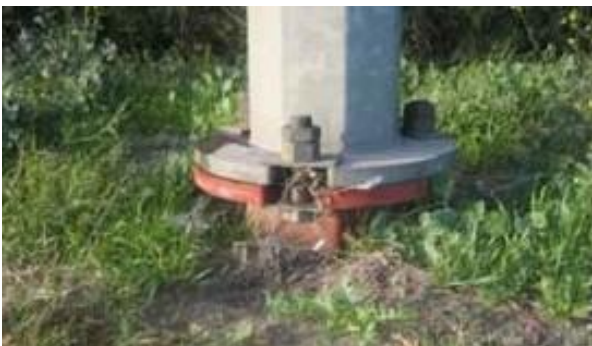
Figura 5.169: Coluna de iluminação com base deslizante adequada para estradas de alta velocidade com pouca atividade de pedestres e de estacionamento.
