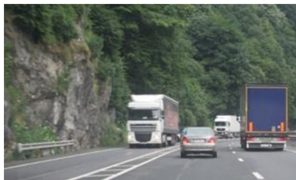
Figura 5.60: Rodovia 2+1 com canteiro central pintado.
