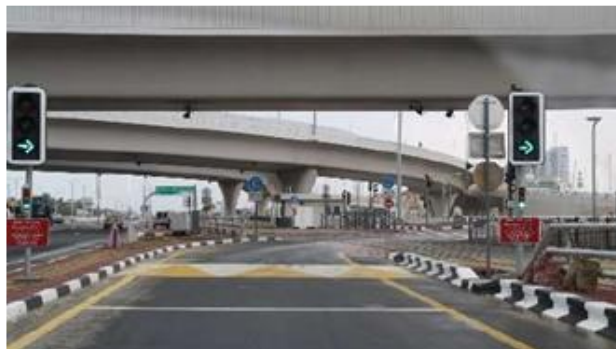
Figura 6.86: Travessia automática de bondes controlada por sinalização – Dubai.
