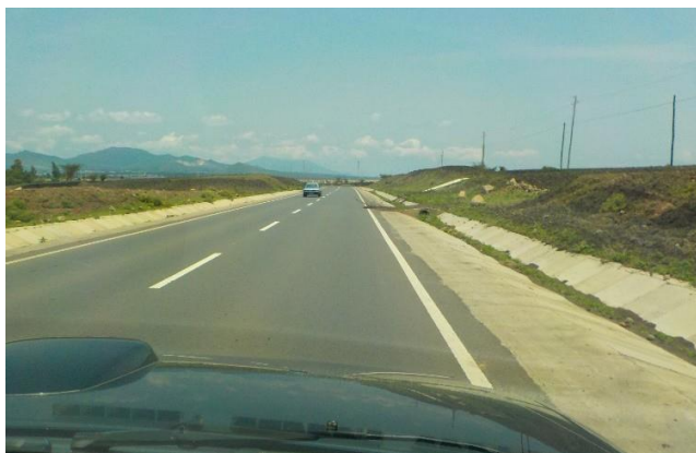
Figura 5.62: Vala perigosa com parede frontal perigosa (direita) em via de alta velocidade.
