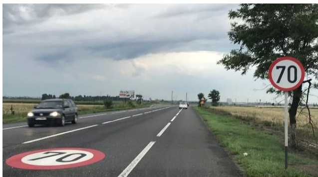
Figura 5.12: Acostamento de 2,5 m usado indevidamente por pessoas como faixa de trânsito – Romênia
