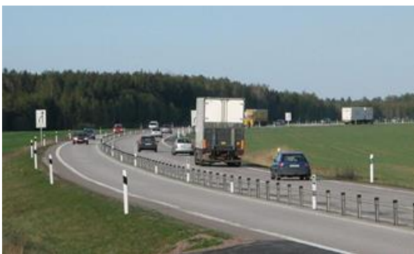
Figura 5.59: Rodovia 2+1 com barreira flexível.
