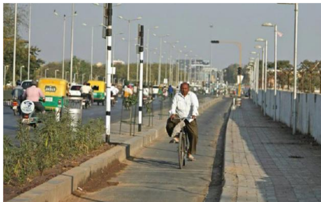
Figura 4.36: Ciclovía separada da via, paralela a uma autoestrada na Etiópia.
