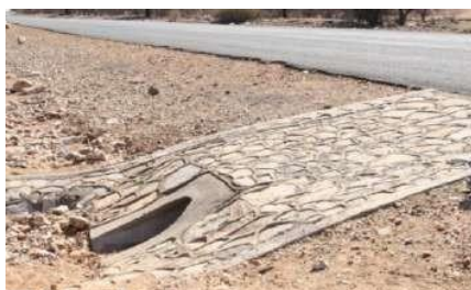
Figura 5.132: Projeto típico de bueiro estendido e projeto revisado de cabeceira.
