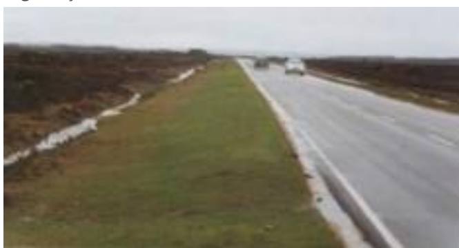
Figura 5.144: Acostamento e drenagem alargados com segurança.
