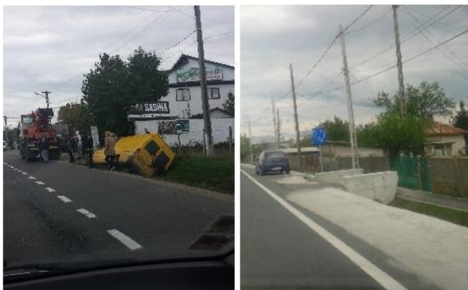
Figura 5.66: Dreno descoberto e bueiro inseguro – Romênia.
