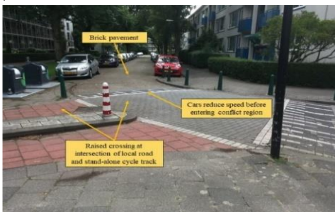
Figura 6.50: Cruzamento elevado com padrão diferente do pavimento.
