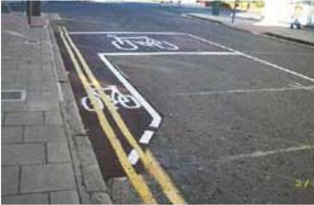
Figura 4.42: Linha para parada avançada dedicada as bicicletas (bike box) com ciclofaixa em contrafluxo.
