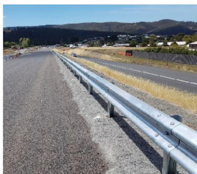
Figura 5.81: Barreira semirrígida (viga W).
