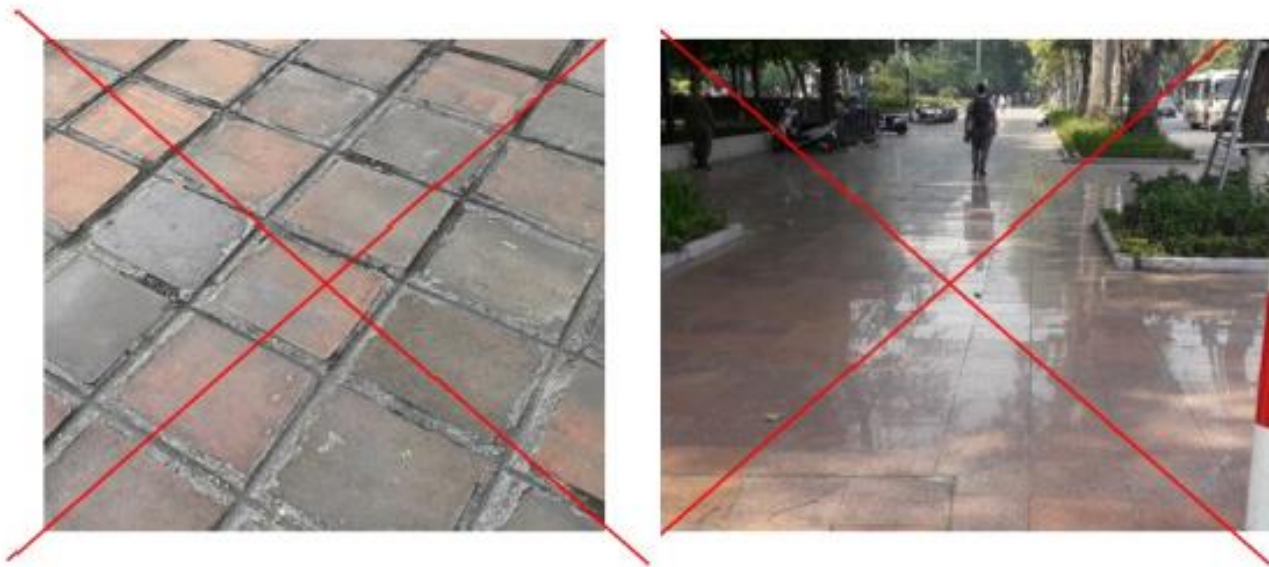
Figura 4.2: Perigo de tropeçar ou piso derrapante.
