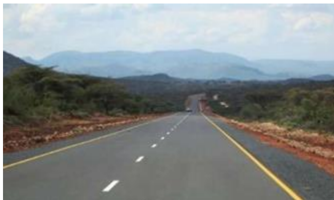
Figura 5.120: Superfície asfaltada em boas condições.
