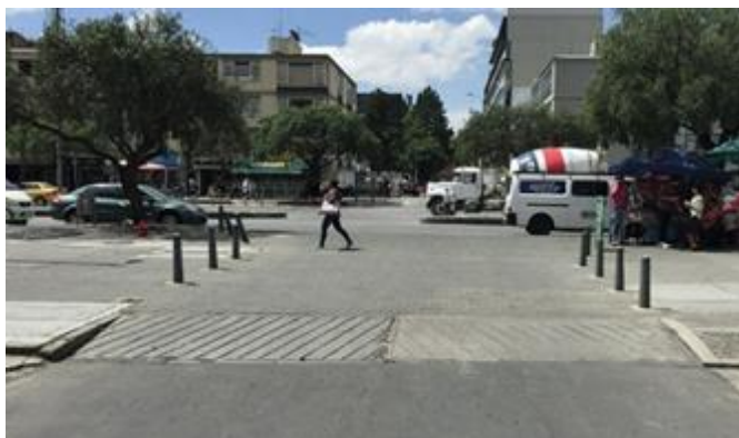
Figura 6.48: Cruzamento elevado em Bogotá para dar prioridade aos pedestres em uma via arterial.
