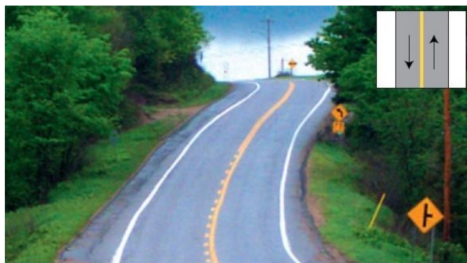
Figura 5.27: Curva horizontal na base de um declive acentuado com sinal de aviso prévio.
