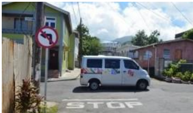
Figura 6.8: Sinalização proibindo a conversão virar à esquerda e demarcação de “Pare” na superfície do pavimento, em cruzamento não sinalizado na Dominica.
