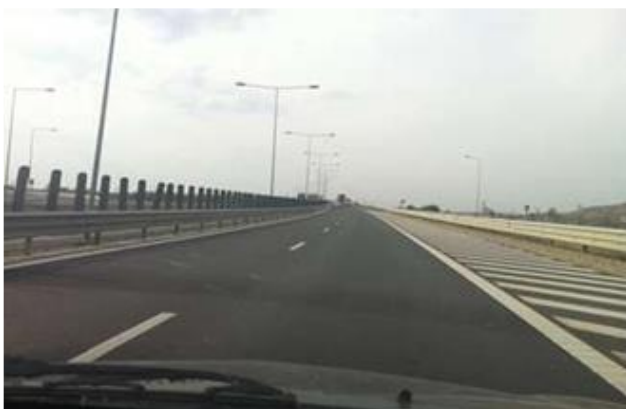
Figura 5.116: Barreira anti-ofuscante no meio do canteiro central.
