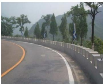
Figura 5.35: Barreira de concreto em seção curva com sinais de alinhamento em forma de chevron.
