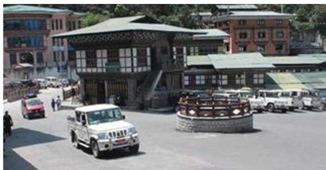
Figura 6.35: Localização e tamanho inadequados da rotatória no Butão.
