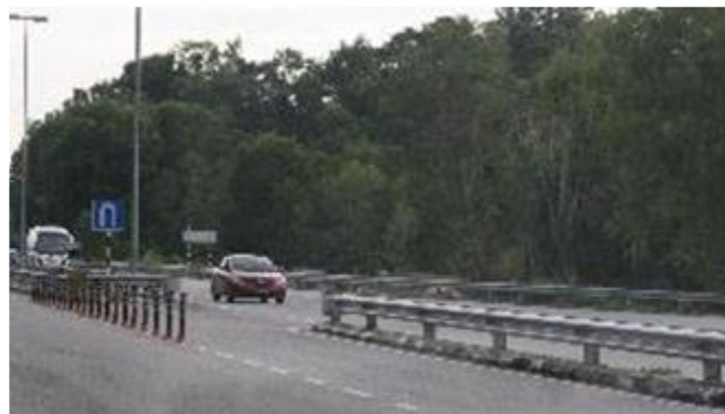
Figura 6.81: Barreira adicional para desvio fora da pista para controlar a entrada e a área de conversão além da faixa de rodagem mais distante para TODOS os veículos, acrescentando uma convergência adicional após cruzar o tráfego oposto- Brunei
