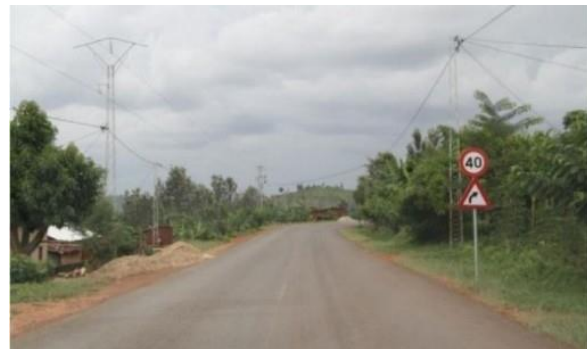
Figura 5.26: Sinal de alerta de curva e sinalização de velocidade.
