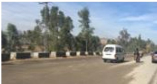
Figura 5.85: Uso de canteiro central fora do padrão em vias de alta velocidade.
