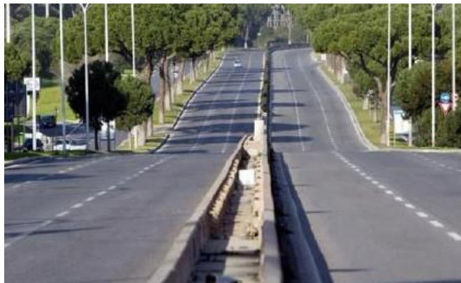
Figura 5.149: Meio-fio vertical perigoso em estrada de alta velocidade.
