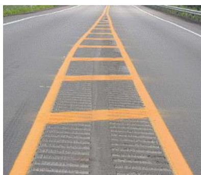
Figura 5.97: Mediana nivelada e com faixas de vibração.
