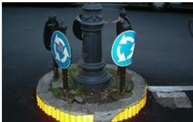
Figura 6.47: Exemplo de mini rotatória com pintura retro refletiva na Itália.
