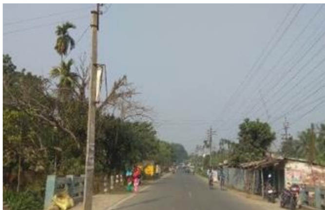
Figura 5.70: Poste rígido no acostamento.
