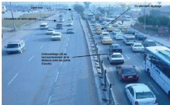
Figura 5.108: Retorno em canteiro central estreito (com faixa de espera).
