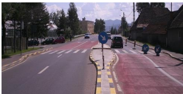
Figura 4.26: Aproximação da travessia com pintura e estreitamento.
