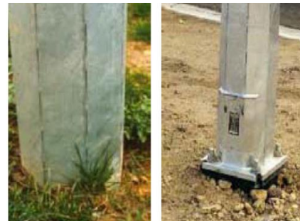
Figura 5.76: Colunas de iluminação com absorção de impacto adequadas para ambientes de baixa velocidade com maior atividade de pedestres ou de estacionamento.
