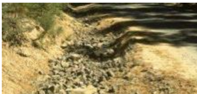
Figura 5.145: Vala à beira da estrada feita com rocha de diferentes tamanhos (enrocamento) para controle de erosão.
