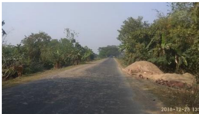
Figura 5.71: Materiais empilhados à beira da estrada. Estes são um perigo particular para veículos de duas ou três rodas, especialmente à noite.
