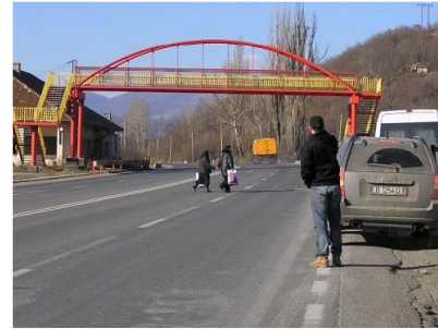
Figura 3.26: Canteiro central mal concebido para impedir a travessia de pedestres – Romênia.
