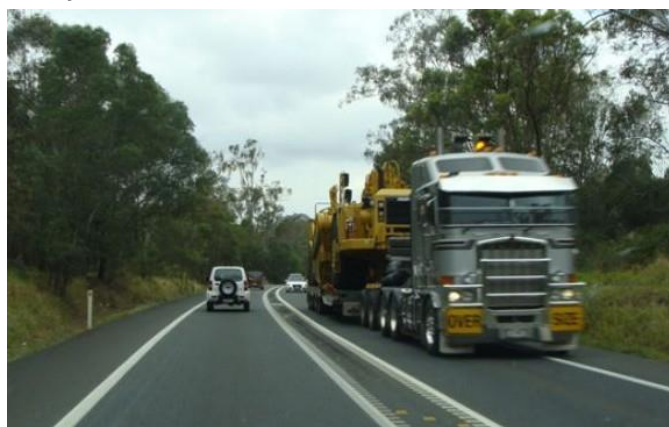
Figura 5.29: Linha central larga com faixas medianas de vibração numa curva na Austrália.
