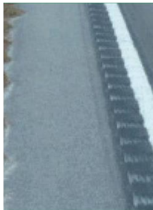
Figura 5.33: Faixas de vibração da linha de borda por fresamento de estrada.
