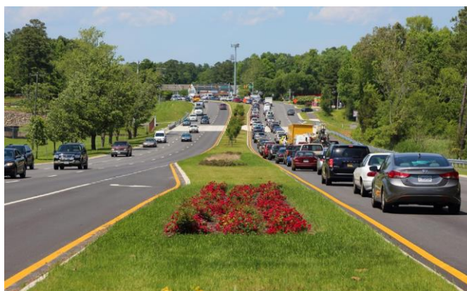
Figura 5.115: Canteiro central elevado na estrada.
