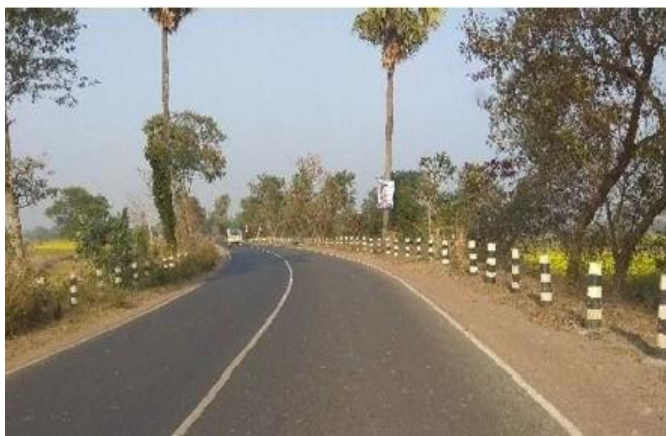
Figura 5.64: Guias de concreto.
