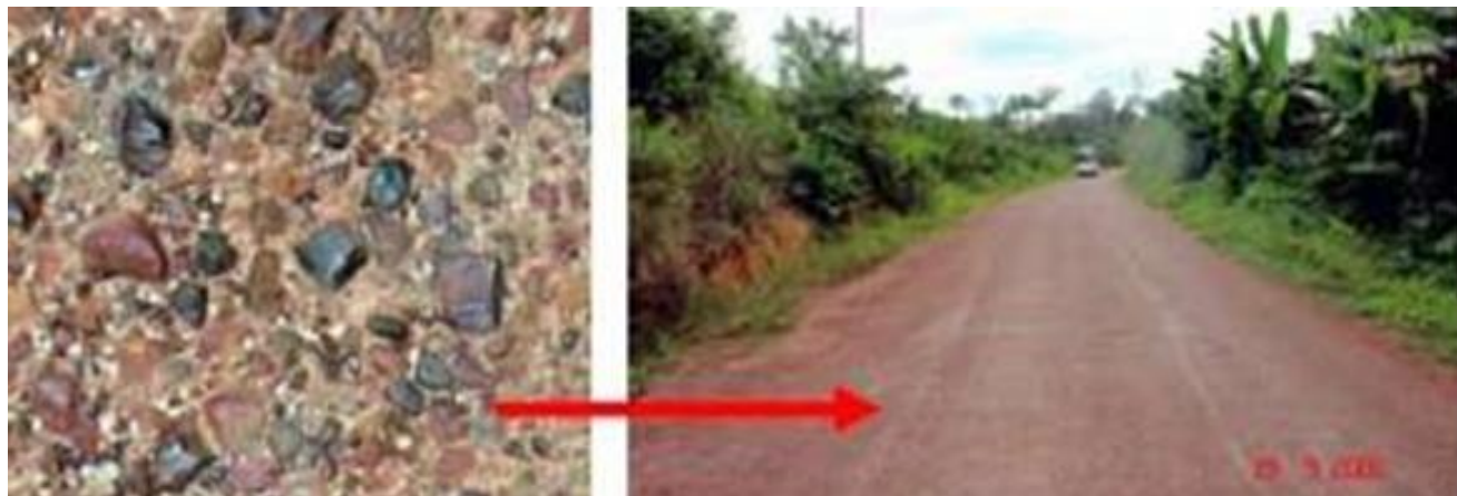
Figura 5.122: Pavimentação da superfície com Otta com resultados satisfatórios em estrada com baixo volume de tráfego e em boas condições. (imagem à esquerda: close-up da pavimentação da superfície com Otta).
