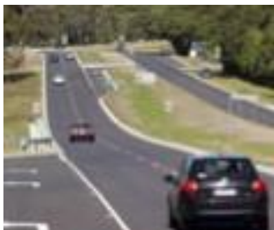
Figura 5.99: Canteiro central gramado e com meio-fio.
