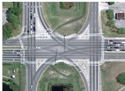
Figura 6.64: Grande interseção urbana com demarcação do pavimento para movimentos de conversão.
