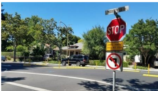
Figura 6.7: Restrição para conversão à esquerda por meio de placas de sinalização e de linha de demarcação no canteiro central, em um cruzamento em T não sinalizado.
