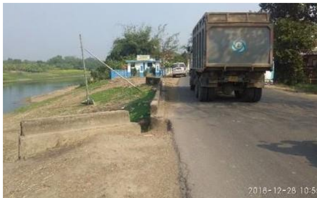
Figura 5.67: Corpo d'água não protegido e com aterro íngreme.
