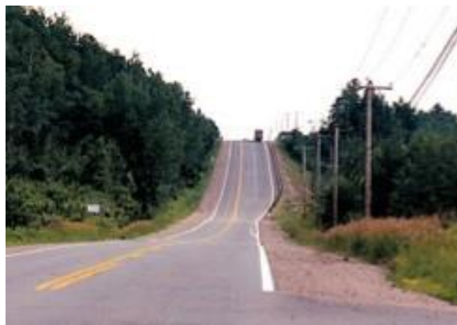
Figura 5.56: Exemplo de marcações em uma pista de subida.
