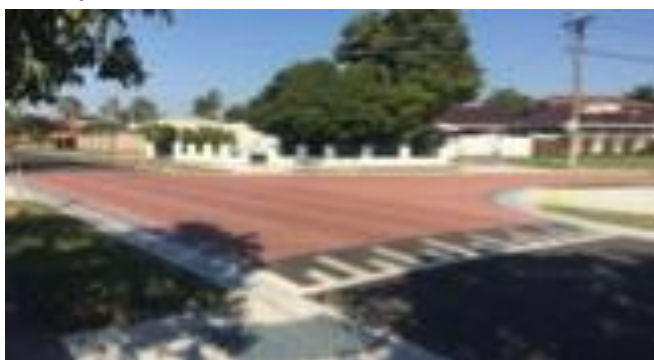
Figura 6.57: Cruzamento sobrelevado, colorido, com marcações de linhas.
