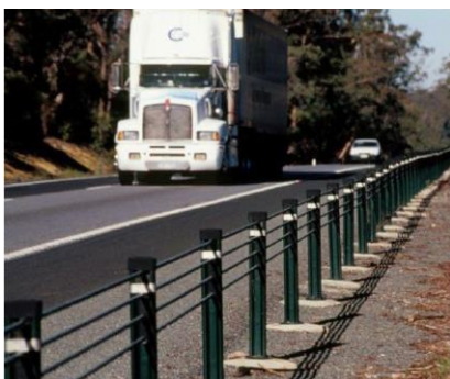
Figura 5.80: Barreira flexível (cabo de aço).
