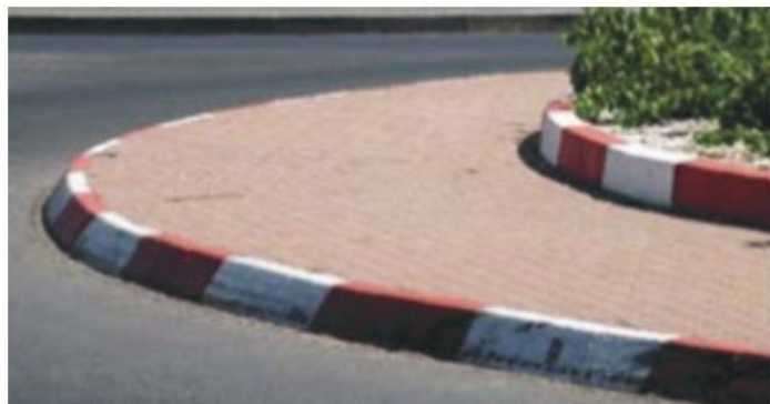
Figura 6.38: Pátio de caminhões que não serve ao propósito do projeto na África do Sul (pátio de estacionamento demasiado alto para caminhões maiores e demasiadamente baixo para bloquear a circulação de automóveis de passageiros).
