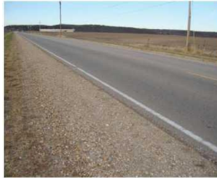
Figura 5.7: Acostamento não pavimentado, feito com cascalho .
