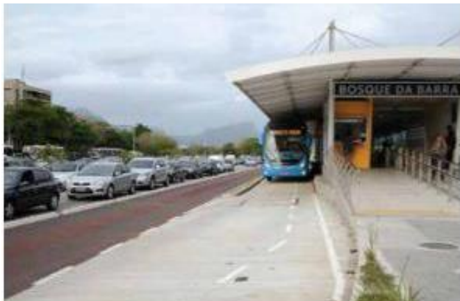
Figura 4.63: Faixas exclusivas BRT.
