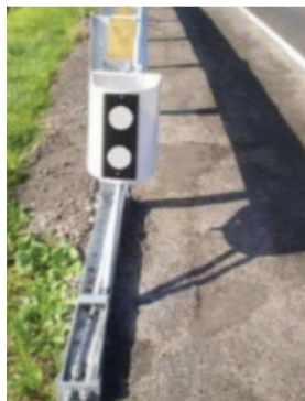
Figura 5.92: Terminal totalmente redirecional, alargado ou tangencial.
