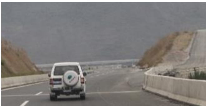
Figura 5.44: Rampa de escape (em construção) na China.
