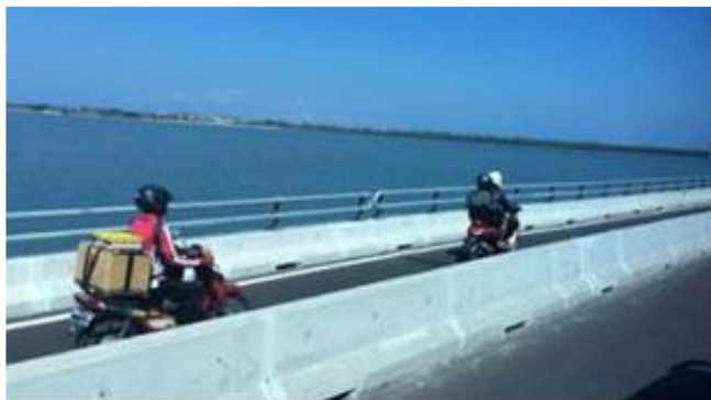
Figura 4.55: Faixa para motocicletas separada por barreira de concreto na Indonésia.
