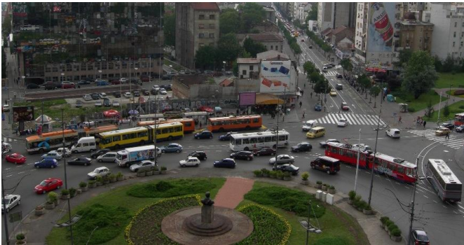
Figura 6.39: Rotatória com linhas de demarcação e largura de faixa inadequados criando faixas adicionais na Sérvia.
