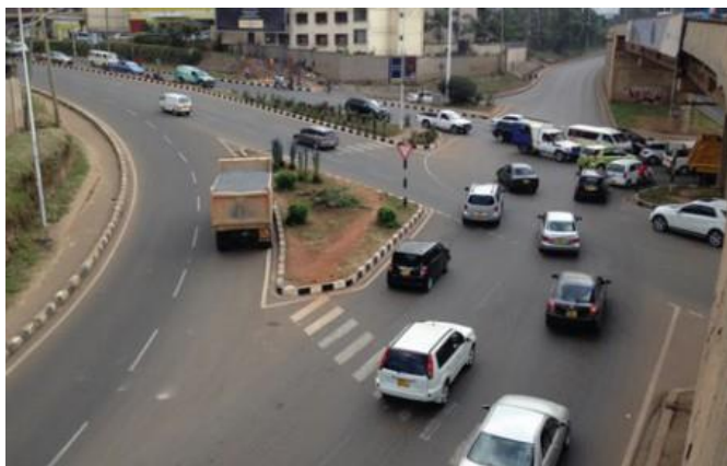
Figura 6.67: Pista de acesso com grande ângulo e cruzamentos mal alinhados e sem possibilidade de travessia.
