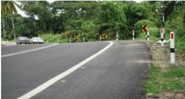
Figura 5.14: Acostamento largo e pavimentado em curva.
