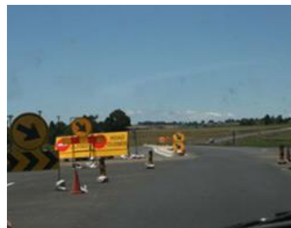
Figura 3.45: Local bem sinalizado e controlado – Tanzânia
