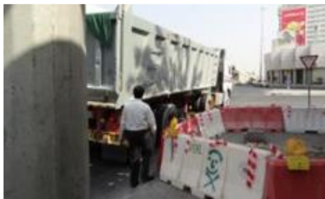
Figura 3.46: Nenhuma provisão para pedestres – Catar.
